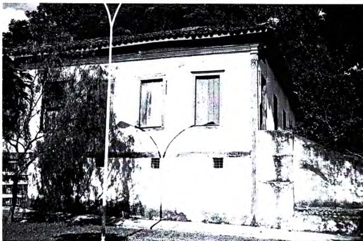
F 13 - Flanco esquerdo da Fachada Lateral Esquerda. Observar perda das folhas de guilhotina da 02 últimas janelas.
