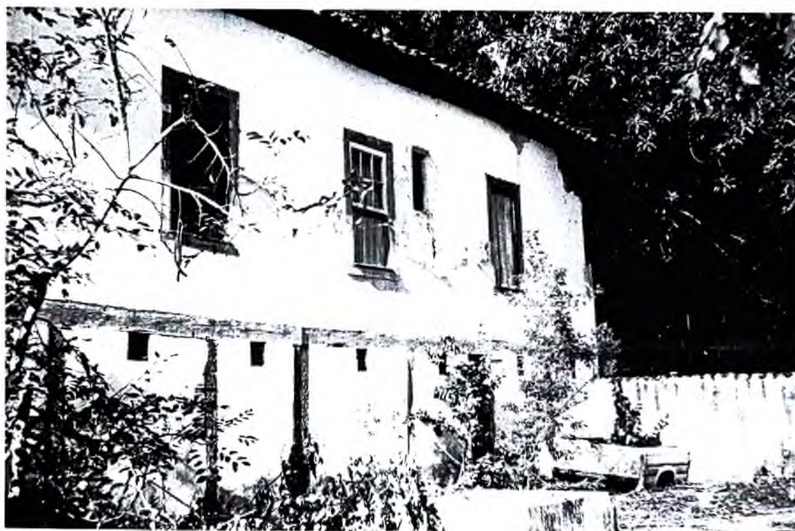
F 16 - Fachada Posterior observada em direção à Fachada Lateral Direita, notando-se vão típico entre as 02 últimas janelas.
