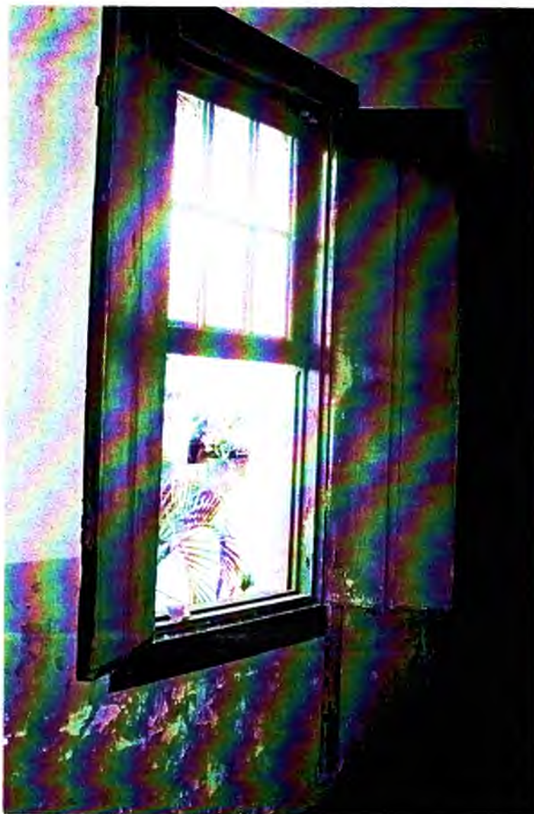
F 26 - Janela JA7, de guilhotina e calha, localizada no cômodo 6.
