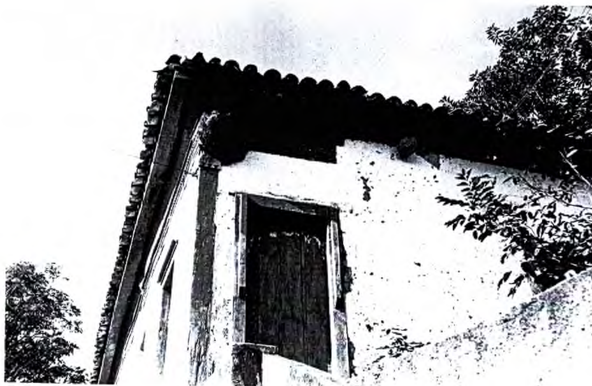
F 14 - Ângulo das fachadas Posterior e Lateral Esquerda, observando-se, sobre a cimalha, caixa de abelhas.
