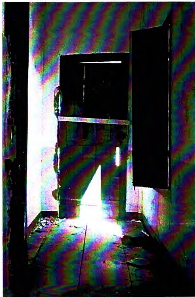
F 35 - Porta PC7, 01 folha de abrir tipo calha, localizada no cômodo 12.
