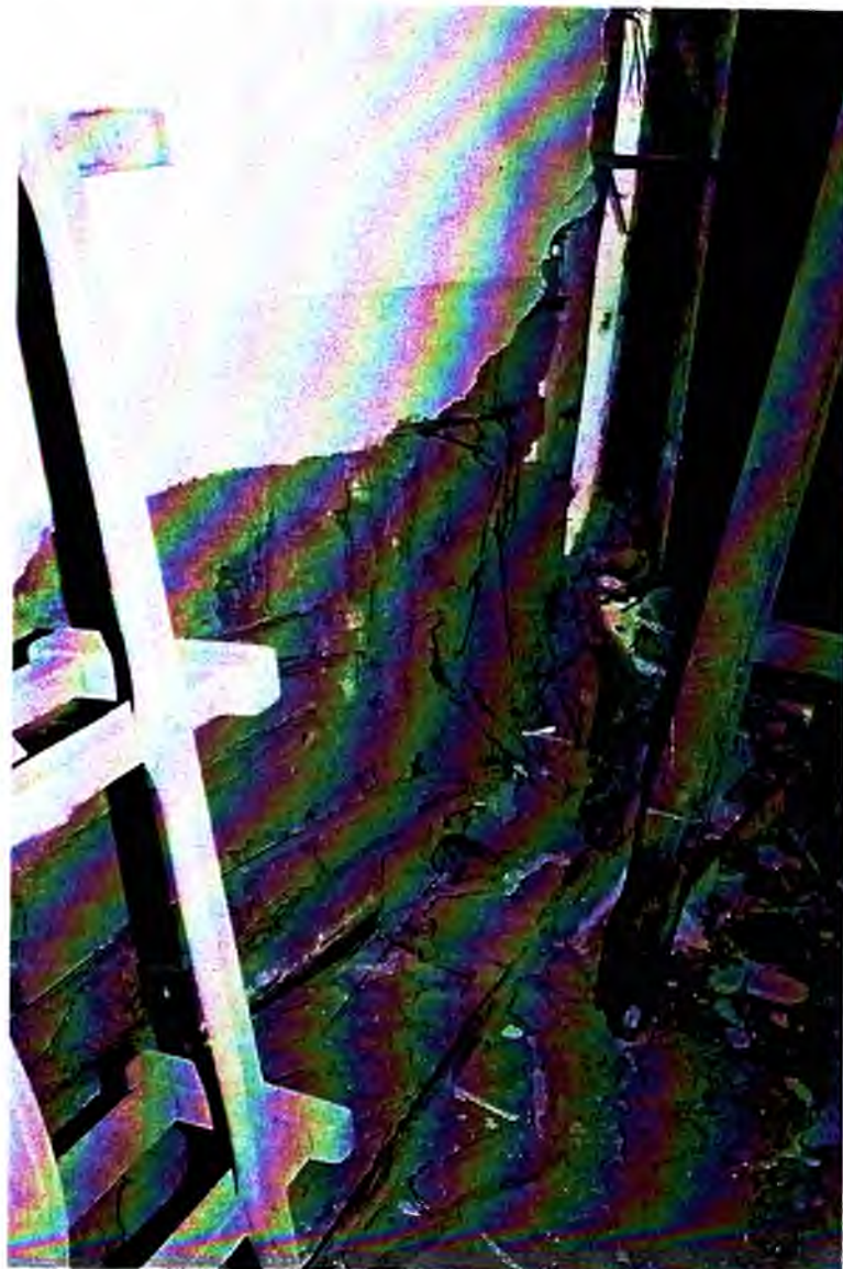
F 41 - Parede de pau-a-pique em processo de arruinamento, localizada no cômodo 16, próximo à JA34.
