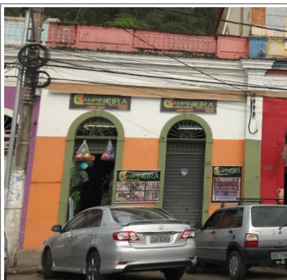
Figura 18 - Banners afixados na fachada do imóvel, além dos engenhos publicitários já existentes.
