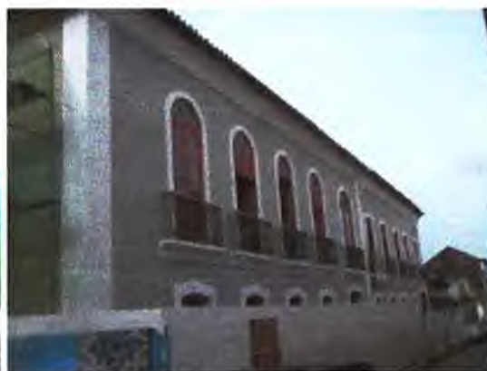
Fachada Secundária (Rua Direita)
