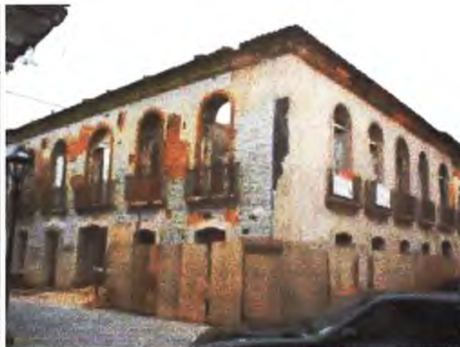
Foto 06 - Fachadas da Rua da Palma, 360 (2005)
