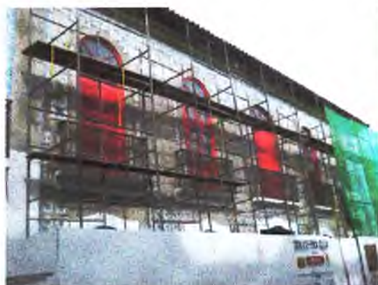
Fachada Principal (Rua da Palma)
