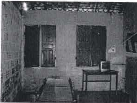
Vista interna de uma das salas com parede em blocos cerâmicos feita posteriormente.
