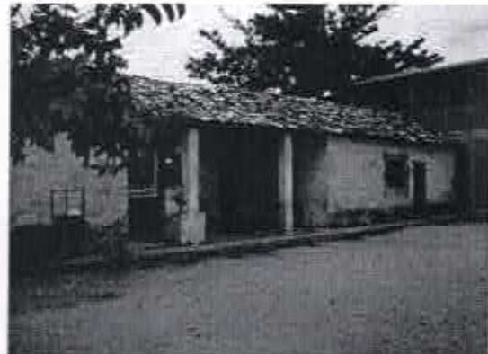
Vista dos fundos da edificação.
