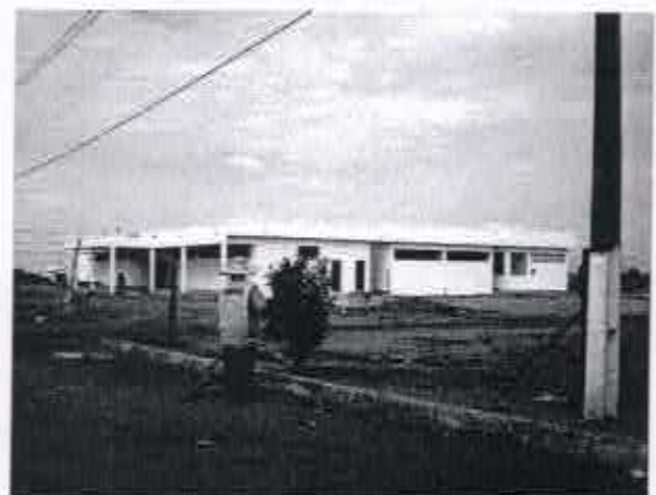
Foto 08 – Distrito Sede Hospital municipal, ainda em fase de construção.
