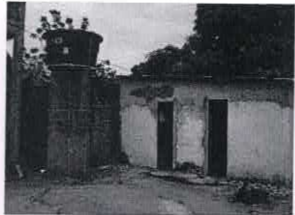
Vista dos banheiros anexados nos fundos em 1980.
