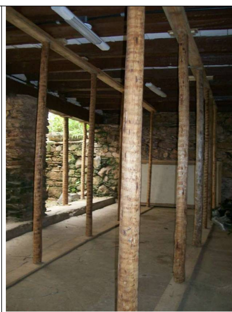
Figura 08 – Escoramento de piso cujo modelo pode ser utilizado em telhados. Fonte: acervo pessoal
