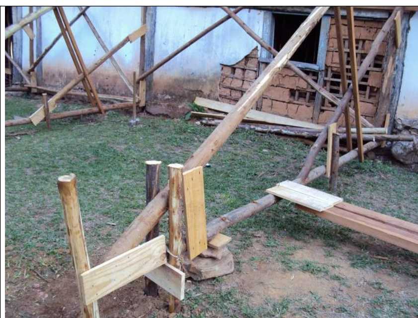
Figura 07 – Detalhe fixação estacas no solo Fonte : acervo do Escritório Técnico do Iphan em São João Del Rei
