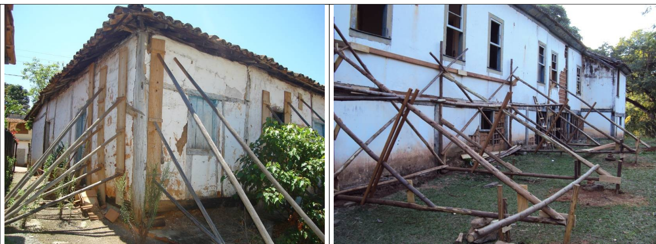
Figuras 05 e 06 – Imagens de escoramentos de fachadas. Fonte : acervo pessoal e do Escritório Técnico do Iphan em São João Del Rei
