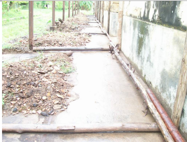
Figura 12 – Início dos trabalhos de escoramento.
