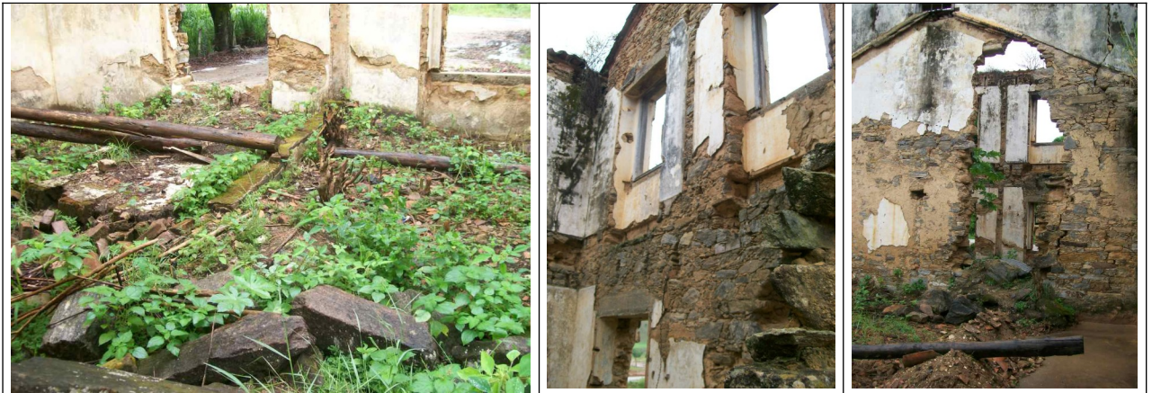
Figuras 16 a 18 – Interior da edificação.
