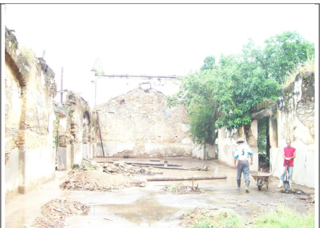
Figura 15 – Interior da edificação.
