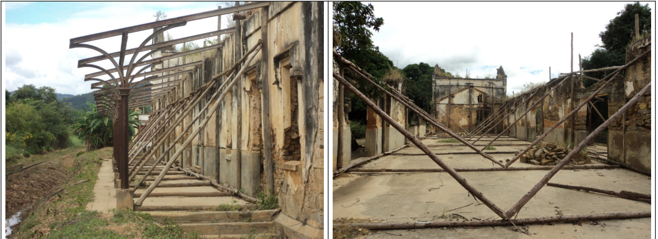
Figuras 19 e 20 – Imagens do escoramento realizado.
