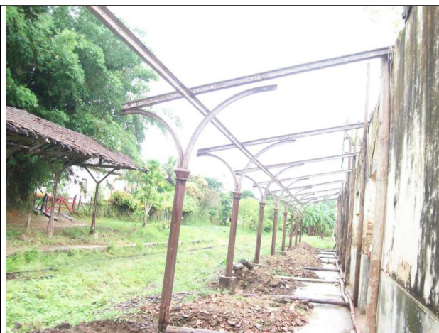
Figura 14 – Estrutura metálica da cobertura da plataforma.
