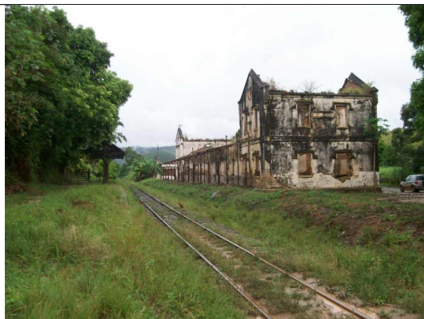
Figura 08 – Vista geral da estação.
