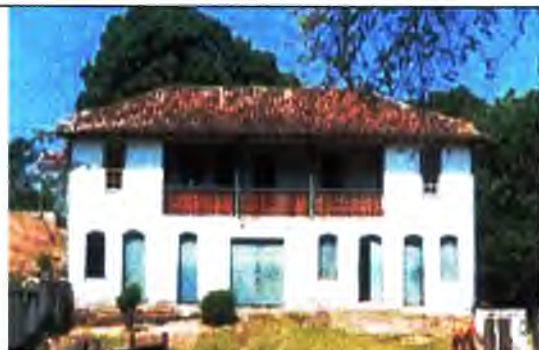
Residência situada à Rua Elizeu Jardim, 333 – Bairro Universitário. Imóvel inventariado pelo município.
