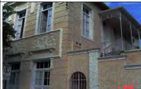
Solar, em estilo eclético, situado à Rua Professor Francisco Santiago 15 – Centro. Imóvel inventariado pelo município.
