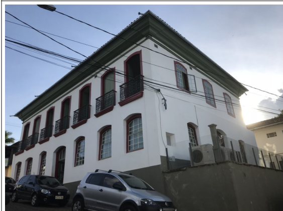
Figura 03 - Fachada frontal da edificação em novembro de 2018.
