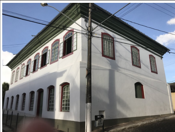
Figura 04 - Fachada dos fundos da edificação em novembro de 2018.
