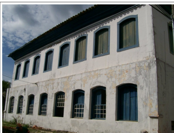
Figura 02 - Fachadas dos fundos da edificação em 2010.
