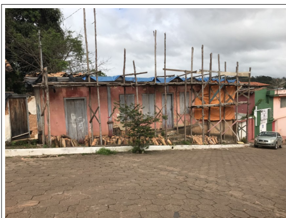
Figura 01 - Fachada frontal da edificação.
