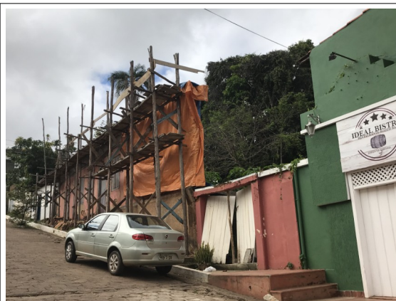
Figura 04 - Trecho remanescente da fachada frontal.
