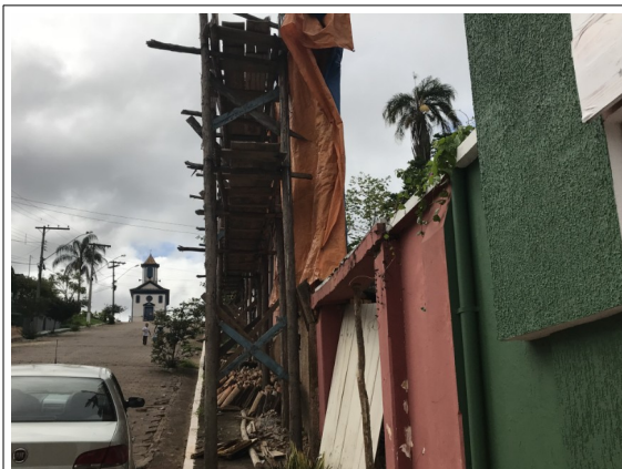
Figura 03 - Trecho remanescente da fachada frontal.
