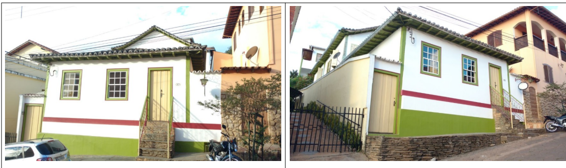
Figuras 3 e 4- Imóvel da Rua Modesto Justino de Oliveira, nº 37. Na segunda imagem é possível visualizar a nova edificação nos fundos do terreno. Fonte: Fotos pelo Conselho Municipal de Patrimônio Cultural de Conceição do Mato Dentro em 16-5-2018.
