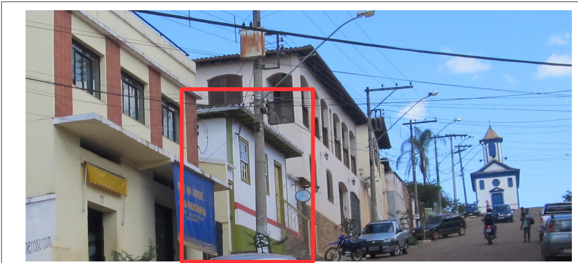
Figura 2- Imóvel situado na Rua Modesto Justino de Oliveira, nº 37 (destacado), próximo à Igreja de Santana. Fonte: Acervo da CPPC, imagem de 2013.
