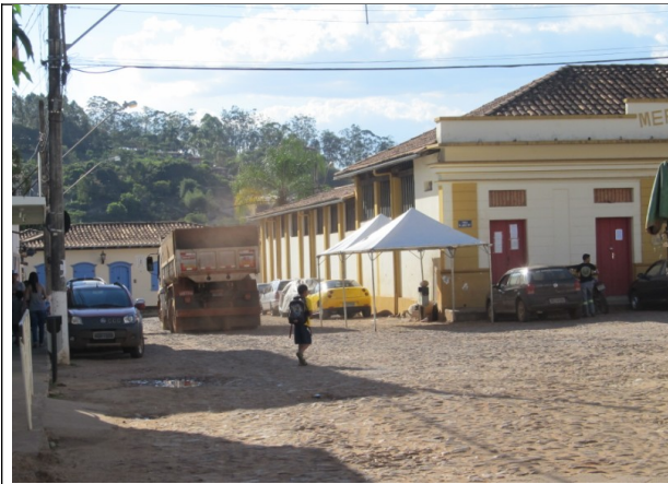
Figura 10 – Circulação de veículos pesados no entorno do Mercado Municipal.
