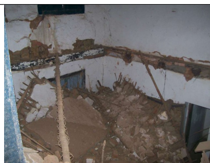
Figura 15 e 16 – Trecho interno onde o piso do segundo pavimento cedeu.
