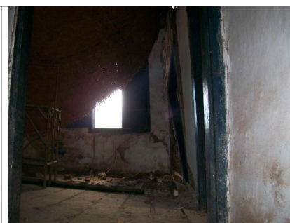
Figura 17 – Vista do segundo pavimento.
