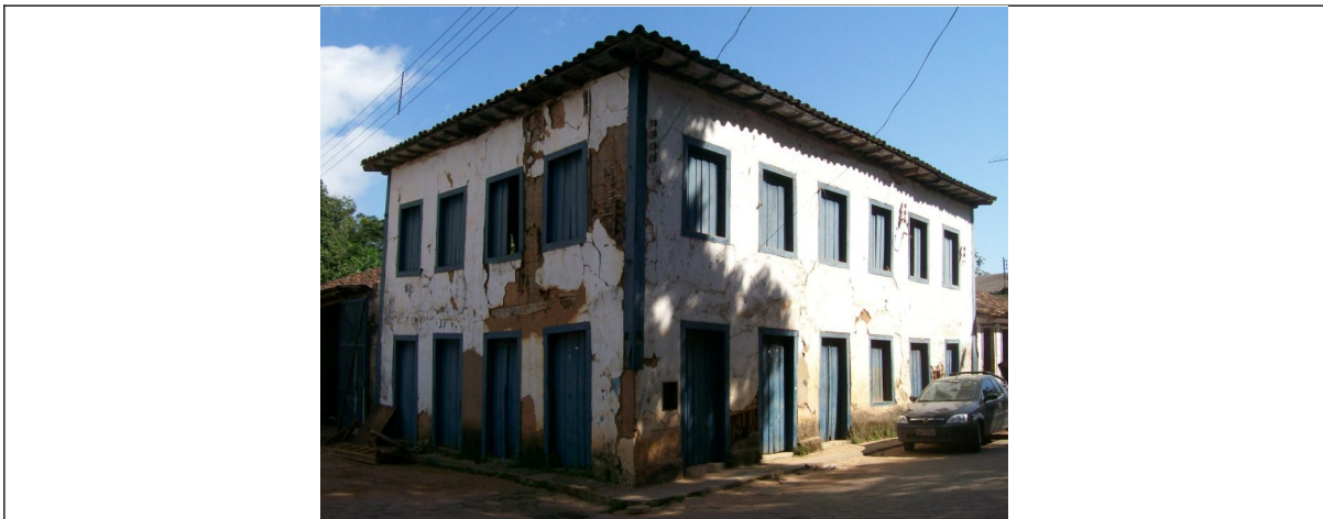
Figura 06- Fachada do imóvel, antes da realização da intervenção.
