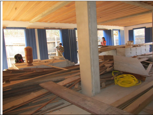
Figura 11 – Vista interna da edificação.
