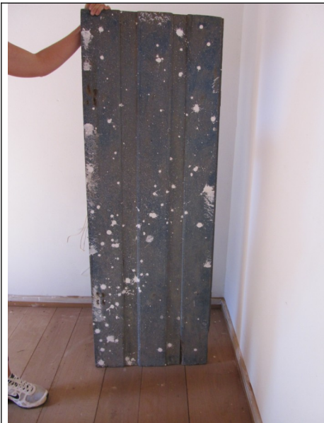
Figura 13 – Esquadria original em bom estado de conservação que não foi utilizada.
