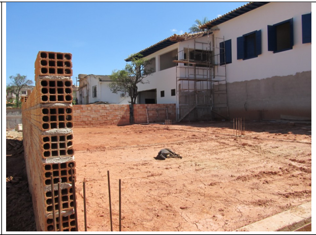
Figura 12 – Obras em andamento nos fundos da edificação.
