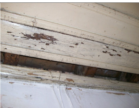
Figuras 09 a 11 – Presença de umidade na edificação.
