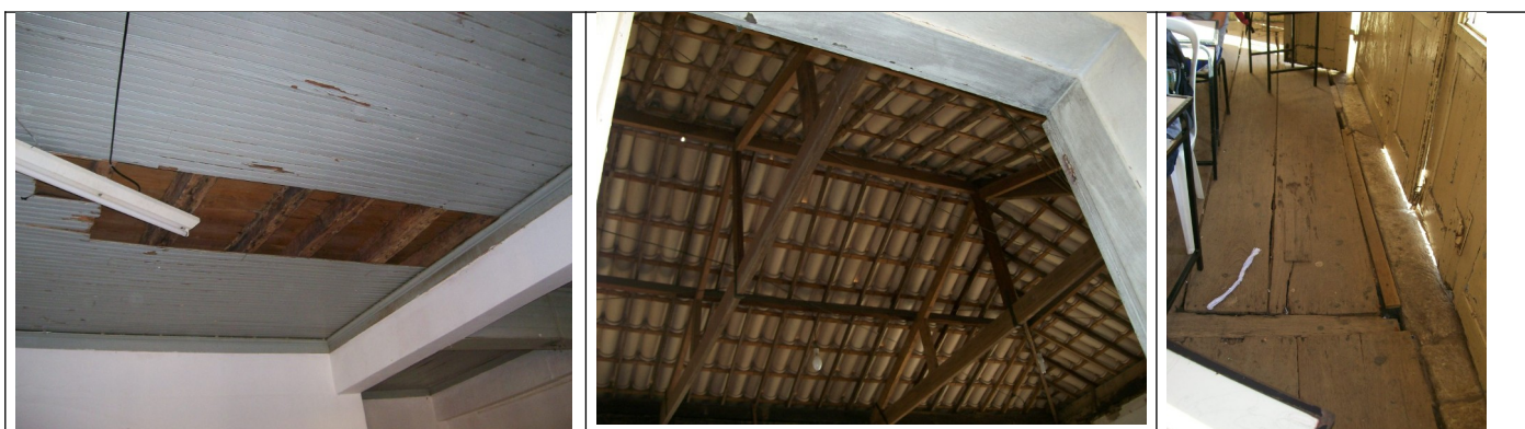
Figura 15 – Forro danificado.
