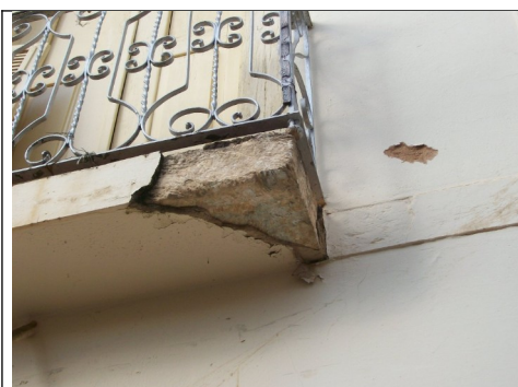
Figura 06 – Descolamento reboco.
