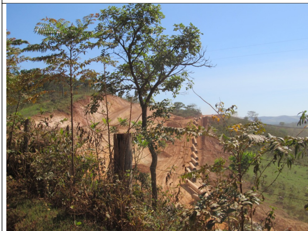
Figura 24 – Obras de implantação do mineroduto na região.
