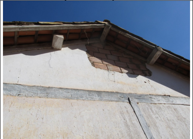
Figura 18 – Complementação da alvenaria em tijolos cerâmicos, sem reboco.
