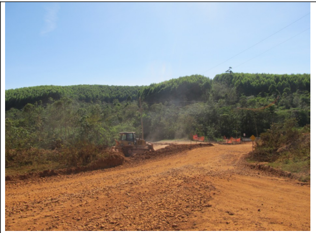
Figura 23 – Obras de implantação do mineroduto junto ao cemitério e plantação de eucalipto.
