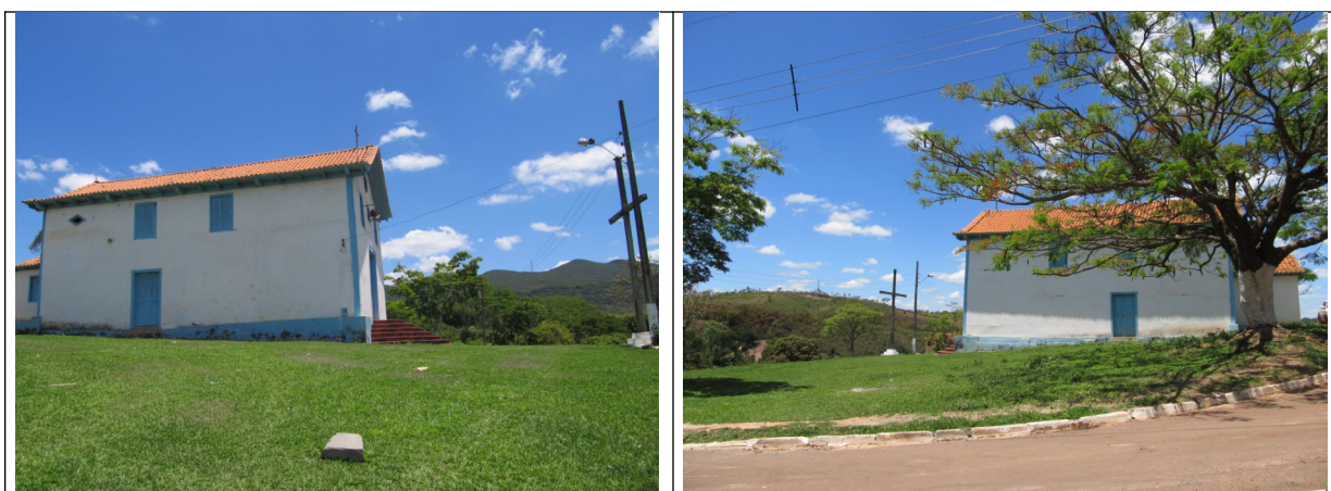
Figuras 14 e 15- Capela de São Sebastião do Bom Sucesso ladeada por montanhas. Foto da vistoria.
