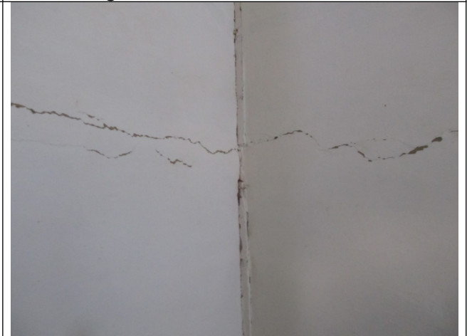
Figuras 20 e 21 – Trincas e fissuras nas alvenarias da Capela.
