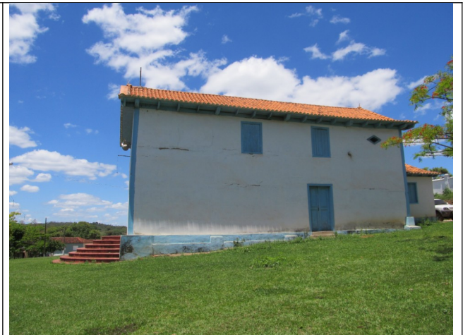
Figura 19 – Fachada lateral direita.
