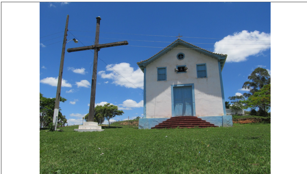
Figura 13- Capela de São Sebastião do Bom Sucesso. Foto da vistoria.
