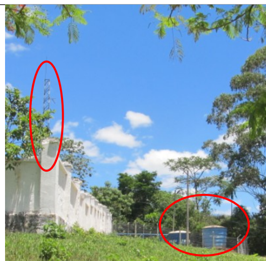
Figura 27 – Antena e caixas d' água junto ao Cemitério.
