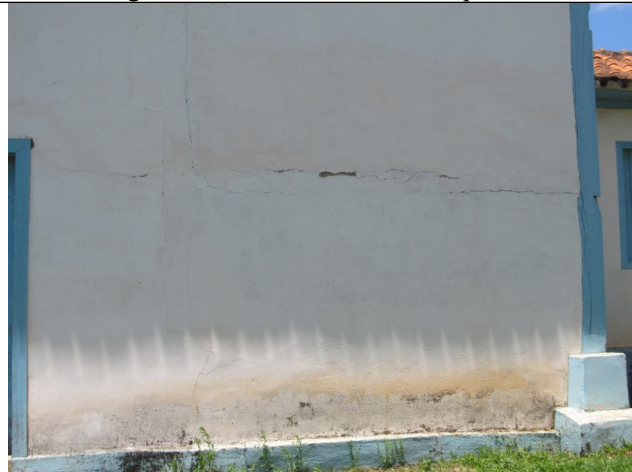
Figuras 20 e 21 – Trincas e fissuras nas alvenarias da Capela.
