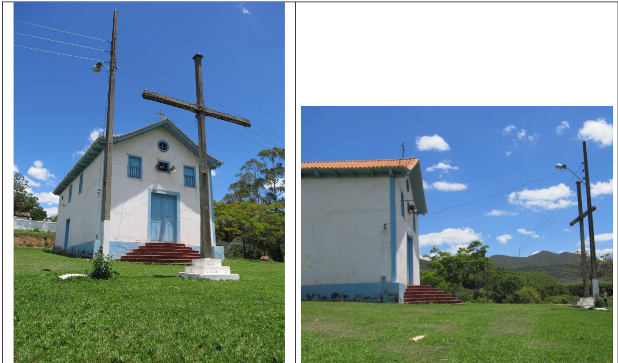
Figuras 28 e 29 – Poste de energia elétrica implantado junto ao cruzeiro, comprometendo a ambiência da Capela.
