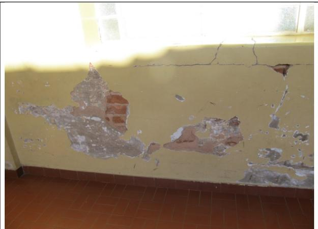
Figura 09 – Trincas e descolamento do reboco.
