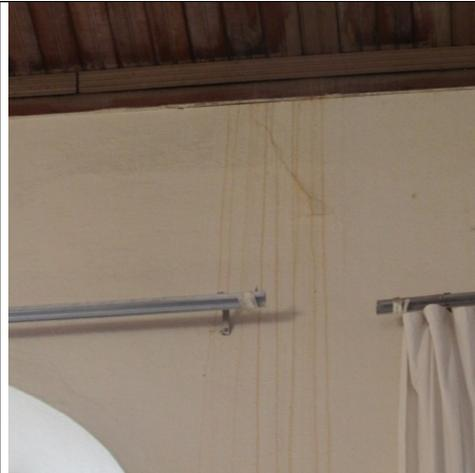
Figura 13 – Marcas de água que escorreu pelas paredes.
