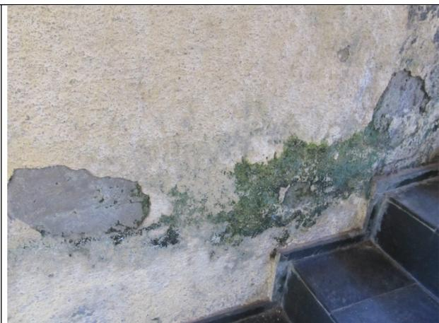
Figura 19 – Umidade junto ao piso.
