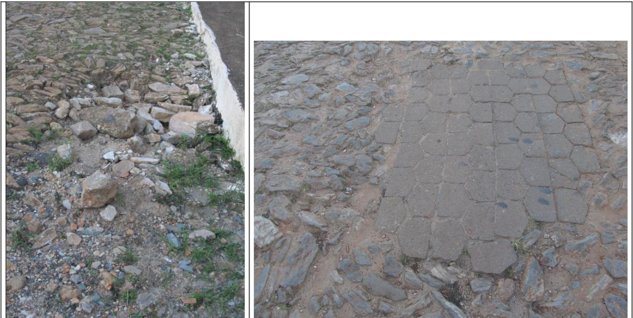
Figuras 13 e 14- Pavimentação danificada e com emendas na Praça do Rosário. Foto da vistoria.
