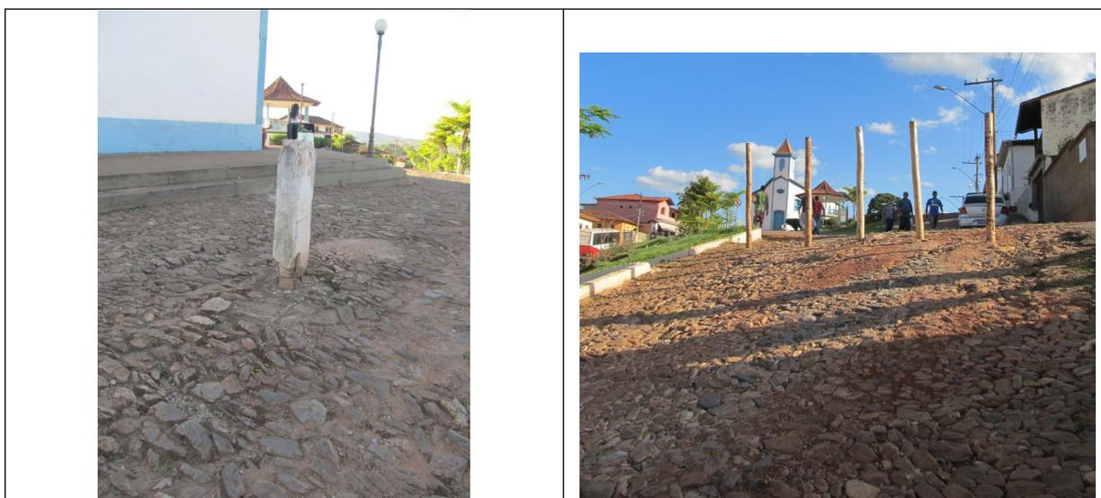
Figuras 11 e 12- Presença de barreiras físicas que visam a limitar o trânsito no entorno da Praça do Rosário em Conceição do Mato Dentro. Na primeira imagem a estaca encontra-se danificada e com as ferragens expostas e a segunda imagem ilustra as estacas provisórias de madeira, ficando no solo. Fotos da vistoria.
