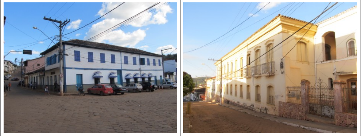
Figuras 34 e 35- Fiação aérea presente no Centro Histórico de Conceição do Mato Dentro. Fotos da vistoria.
