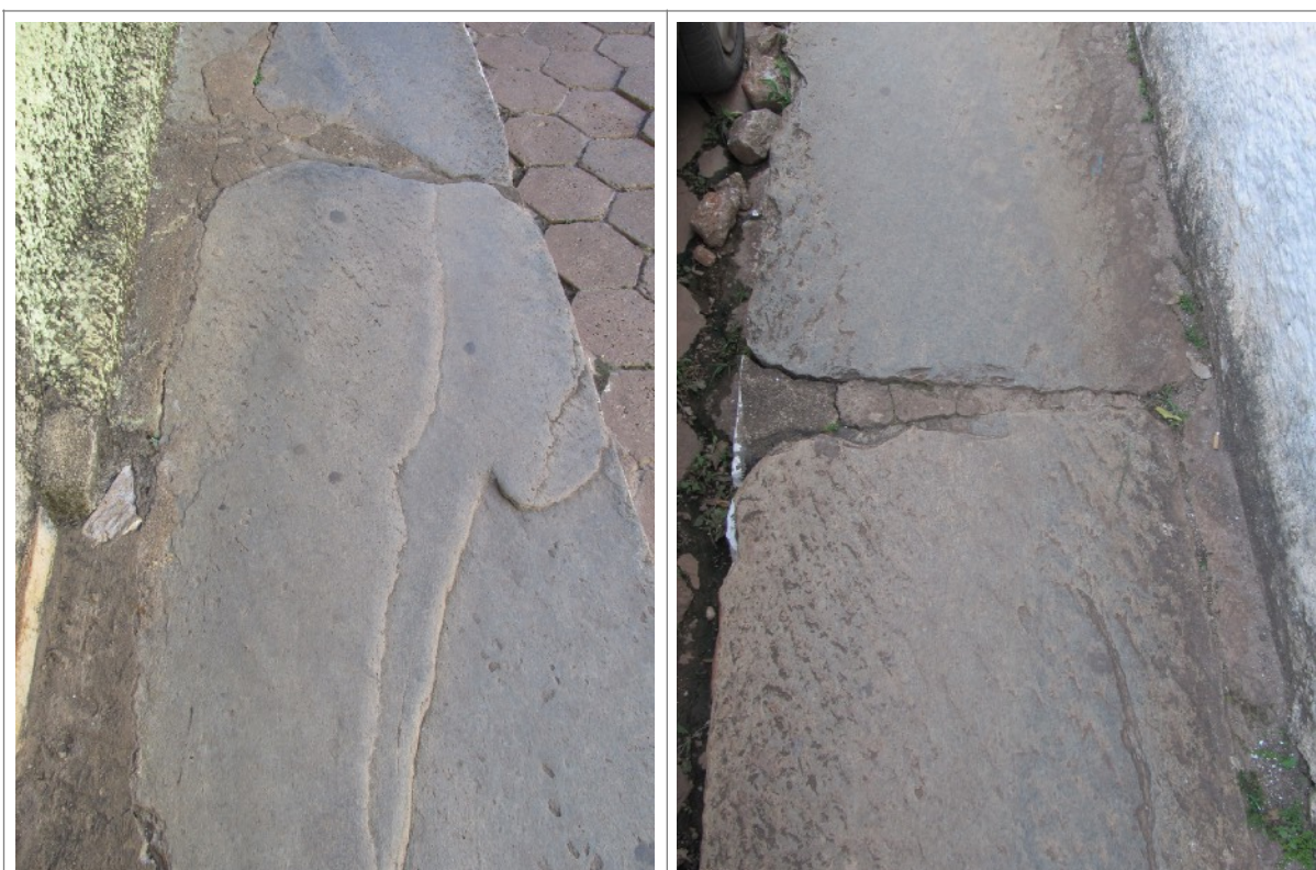
Figuras 32 e 33- Calçadas antigas nas ruas do Centro Histórico de Conceição do Mato Dentro. Fotos da vistoria.
