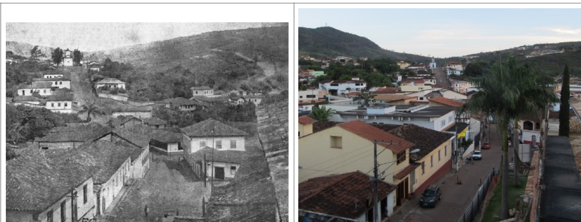
Figuras 44 e 45- Imagem antiga de Conceição do Mato Dentro, tendo ao fundo o Largo de Santana. Fonte: http://cmd.mg.gov.br/galeria-de-fotos . (acesso 16-10-2013) e vistoria realizada na cidade.
