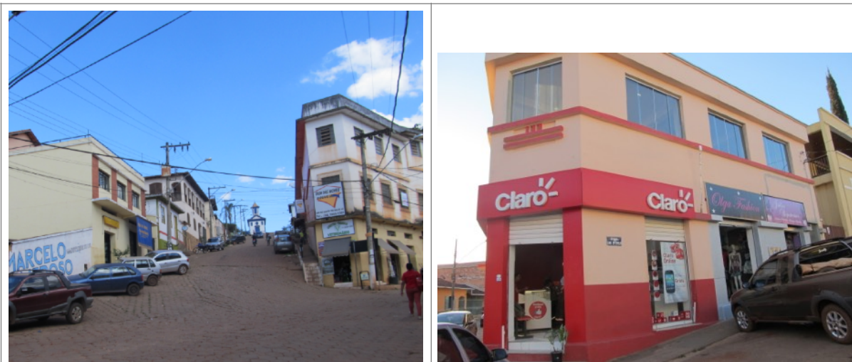
Figuras 42 e 43- Poluição visual no Núcleo Histórico de Conceição do Mato Dentro . Fotos da vistoria.
