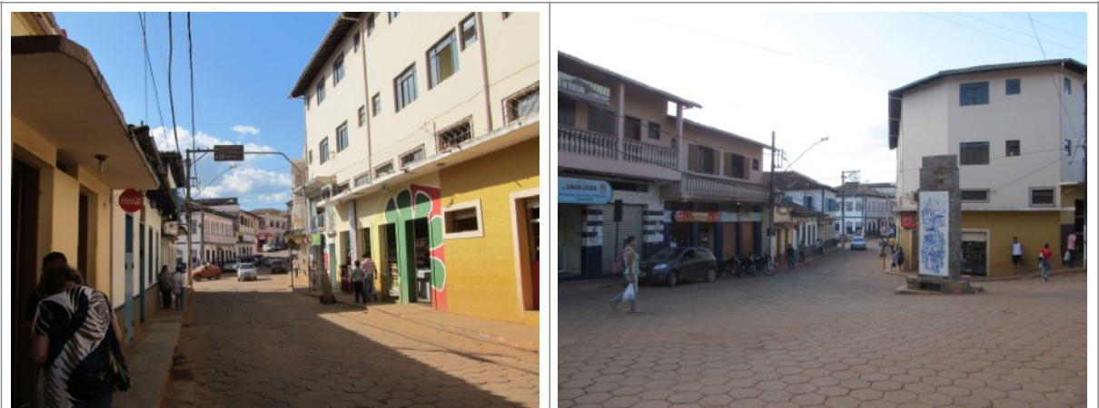
Figuras 36 e 37- Edificações presentes no Centro Histórico de Conceição do Mato Dentro que extrapolam a altimetria dominante. Fotos da vistoria realizada.
