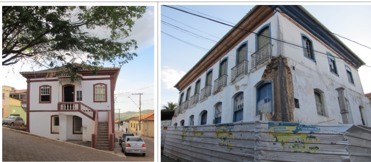
Figuras 12 e 13- Antigo Fórum/ Cadeia Velha e Sobrado da Prefeitura Municipal, respectivamente: bens culturais tombados localizados na Rua Daniel de Carvalho. Fotos da vistoria.
