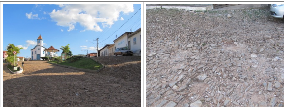
Figura 30 – Pavimentação em pedras existente no Largo do Rosário.
