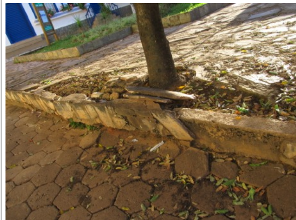
Figuras 31 e 32 – Pavimentação danificada.
