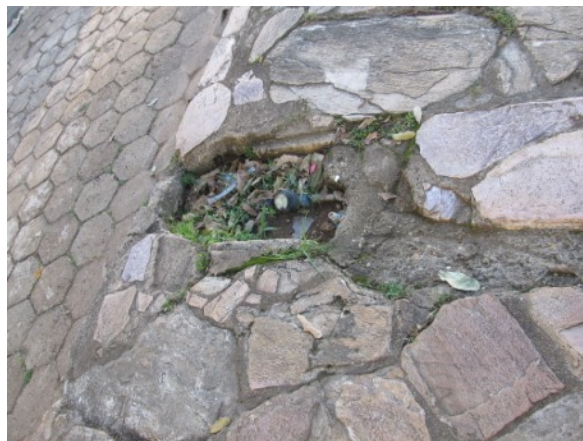
Figuras 31 e 32 – Pavimentação danificada.
