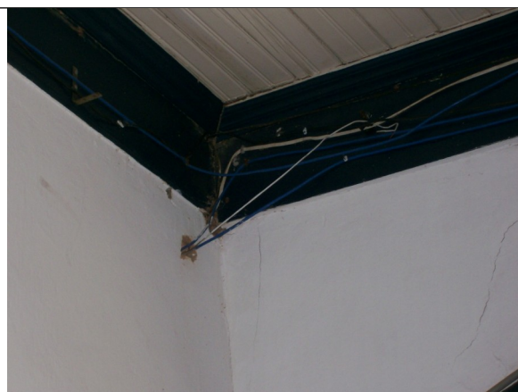
Figuras 17 e 18 – Fiação exposta junto à umidade e gambiarras elétricas.
