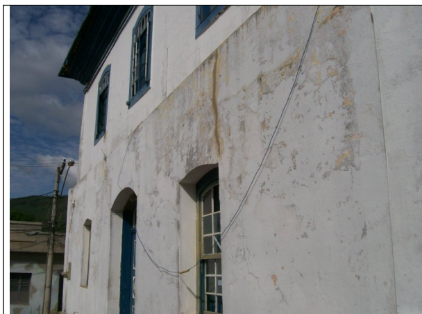
Figuras 08 a 10 – Patologias nas alvenarias e esquadrias.
