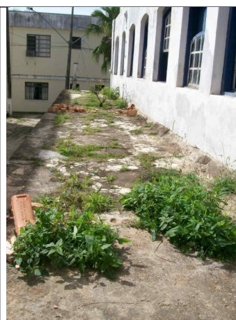
Figuras 14 e 15 – Trincas e plantas invasoras no piso e alvenaria no pátio externo.
