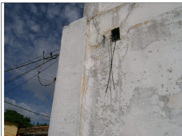
Figuras 17 e 18 – Fiação exposta junto à umidade e gambiarras elétricas.
