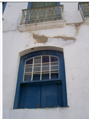
Figuras 08 a 10 – Patologias nas alvenarias e esquadrias.
