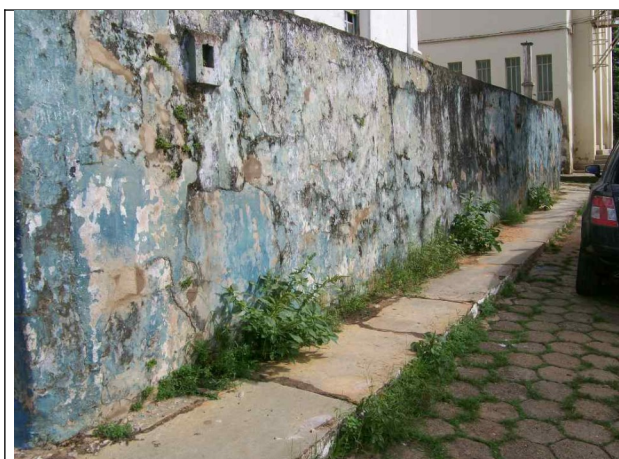
Figuras 14 e 15 – Trincas e plantas invasoras no piso e alvenaria no pátio externo.
