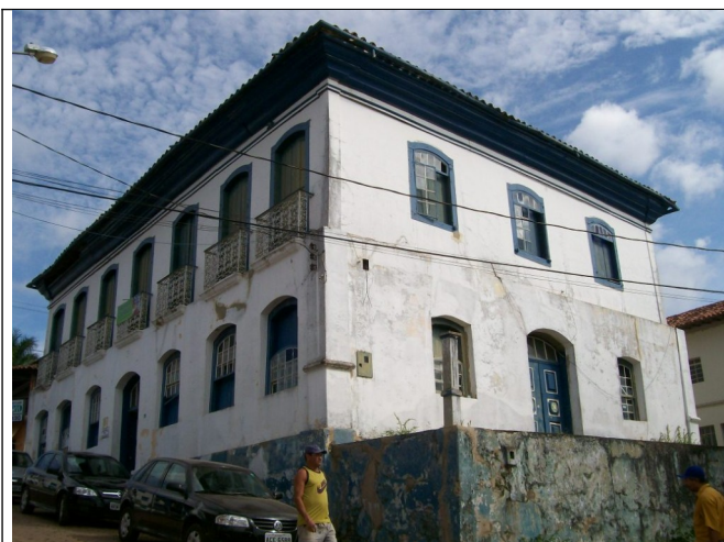
Figura 06 – Fachada principal e lateral direita.
