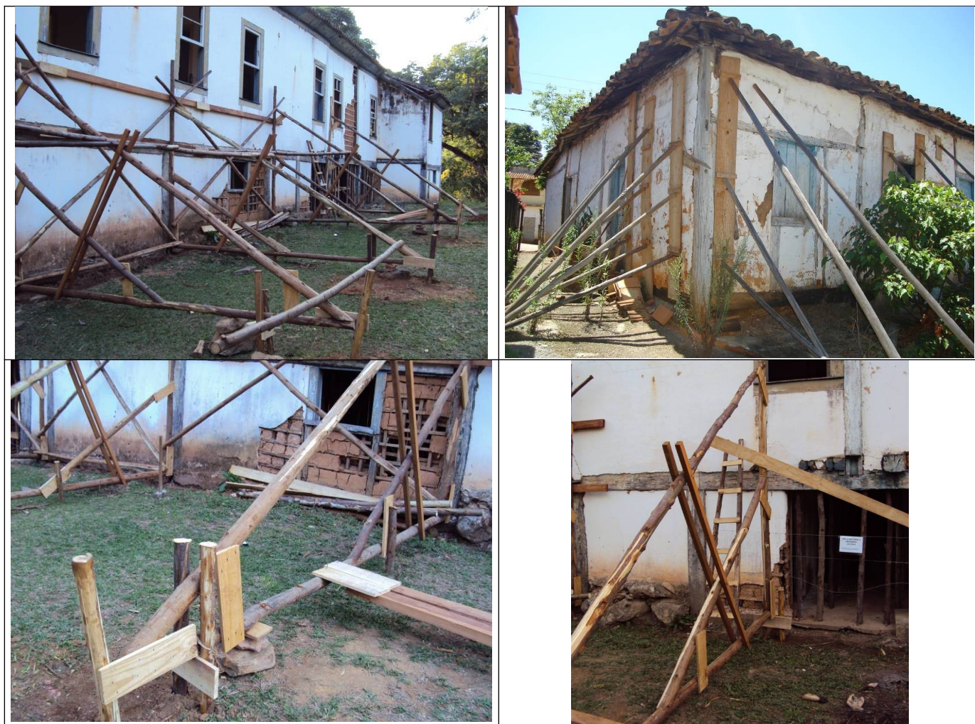
Figuras 04 a 07 – Escoramento de alvenarias.
