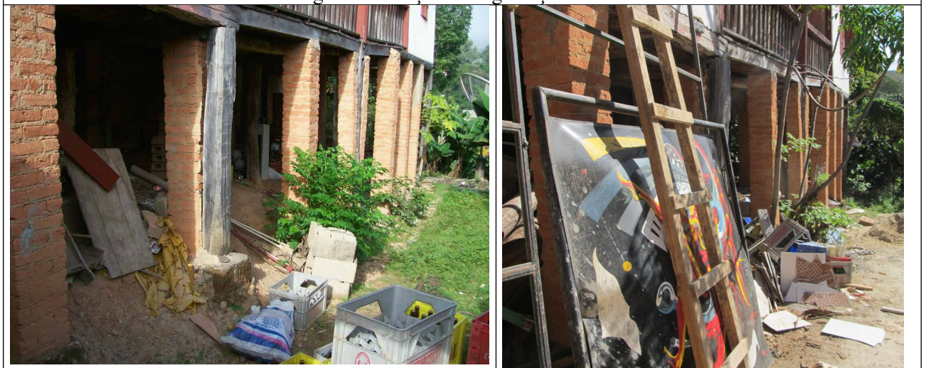
Figuras 12 e 13 – Imagens comparativas do porão da edificação, que continua sendo utilizado como
