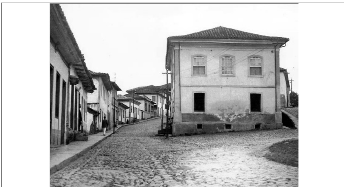
Figura 05- Antiga Casa de Câmara e Cadeia de Conceição do Mato Dentro. Fonte: http://cmd.mg.gov.br/galeria-de-fotos . Acesso 16-10-2013.
