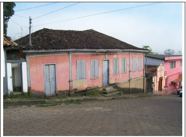
Figura 08 – Foto da vistoria de maio de 2010.
