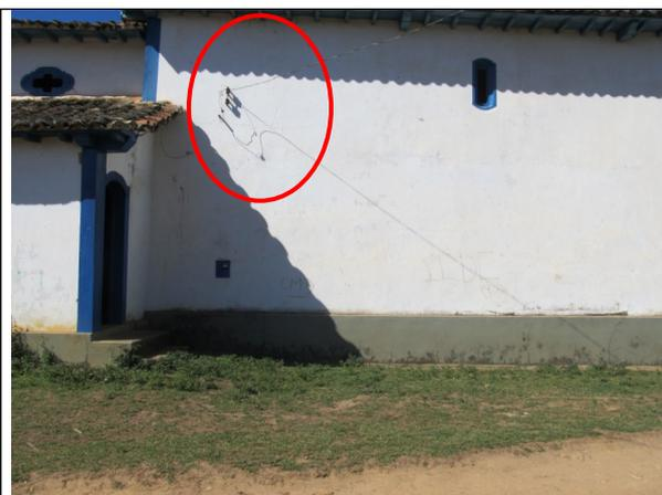
Figura 23 – Fiação elétrica aparente.
