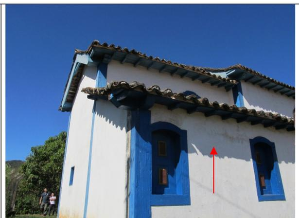
Figura 24- Manchas causadas por infiltração
