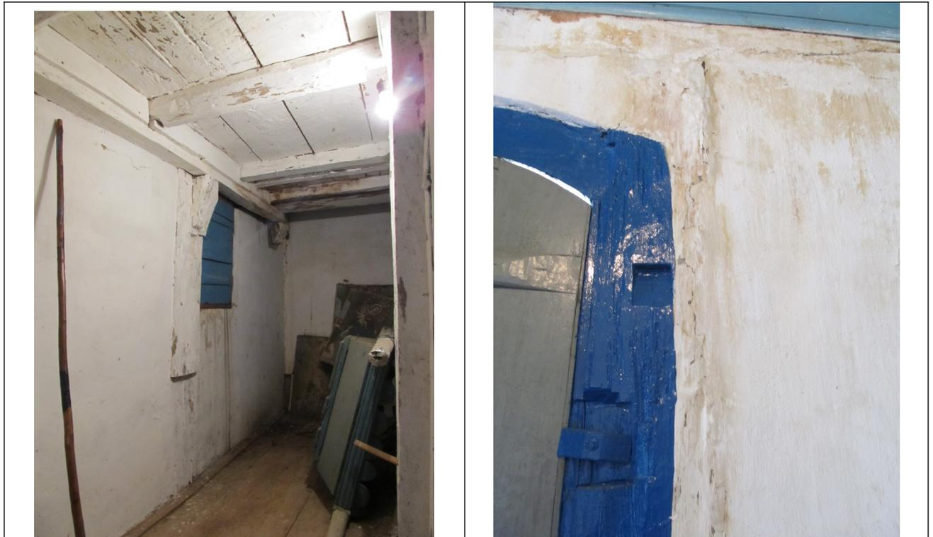
Figuras 17 e 18 – Marcas de infiltração de água e sujidades nas alvenarias no interior da Capela de Santana
