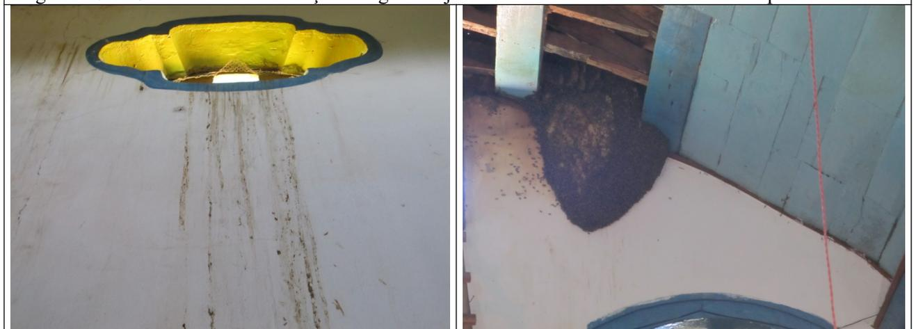
Figura 19- Sujidade na alvenaria da Capela
