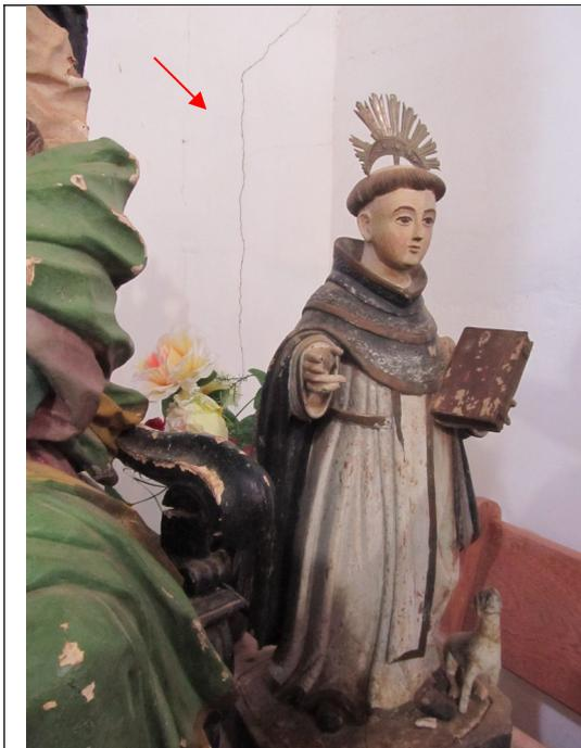
Figura 21- Trinca na alvenaria da Capela.
