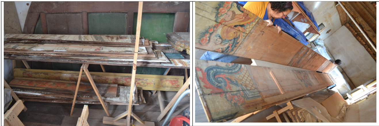
Figuras 36 e 37 – Revestimentos em madeira policromada da parede da sacristia.
