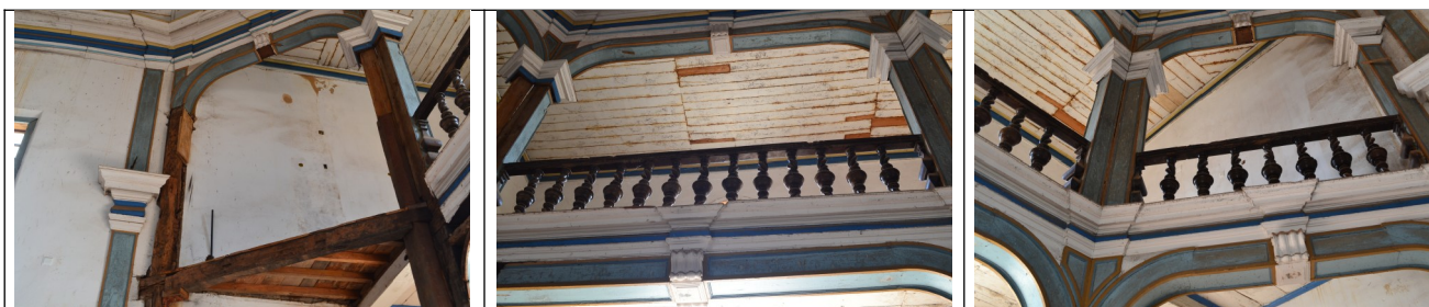
Figuras 46 a 48 – Detalhe das colunas, pilastras e arcadas do coro. Nota-se que, para além de questões estruturais, esses elementos ainda encontram-se repintados.
