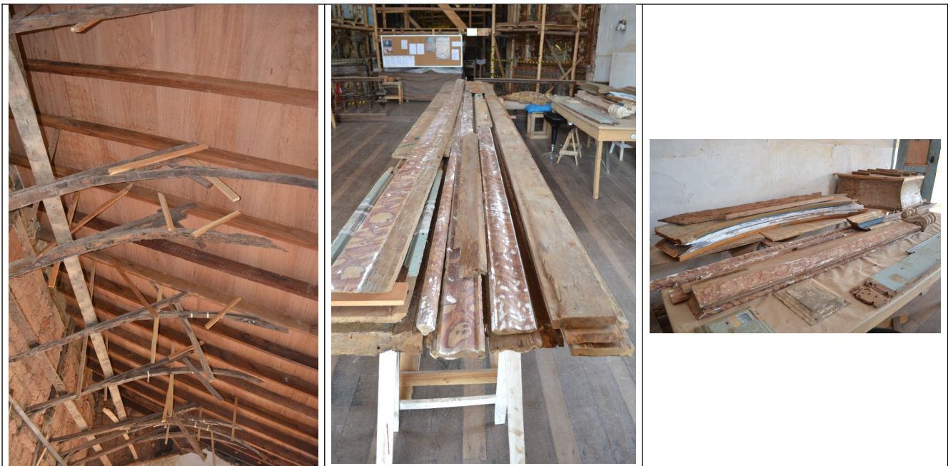
Figuras 29 a 31 – Nas fotografias acima se verifica a retirada do forro da sacristia e as tabulas que integram o forro.
