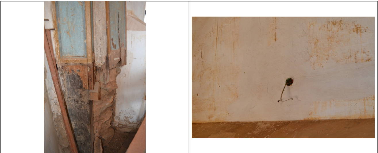
Figura 58 – Estrutura exposta da igreja e ausência de elementos integrados.
