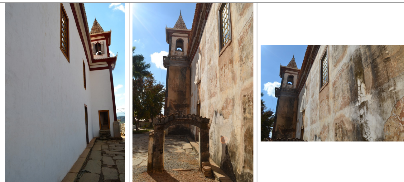
Figuras 51 a 53 – Visada das fachadas laterais do templo. Nota-se a disparidade no que diz respeito ao estado de conservação destas.
