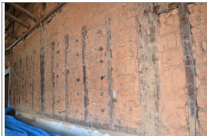
Figura 34 – Parede da sacristia sem o revestimento de madeira policromada e telas.
