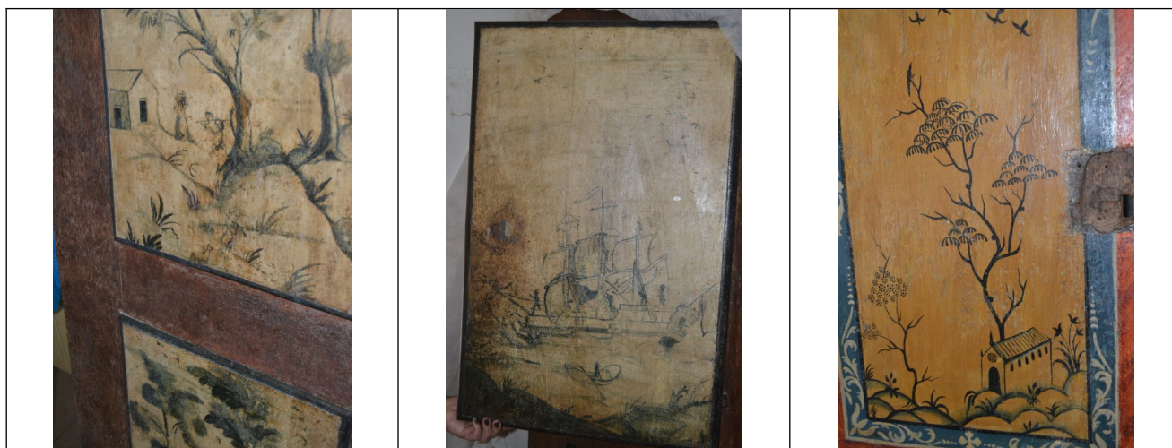
Figuras 26 a 28 – Nas fotografias verifica-se as pinturas encontradas nas portas. Estavam subjacentes às camadas de repintura.
