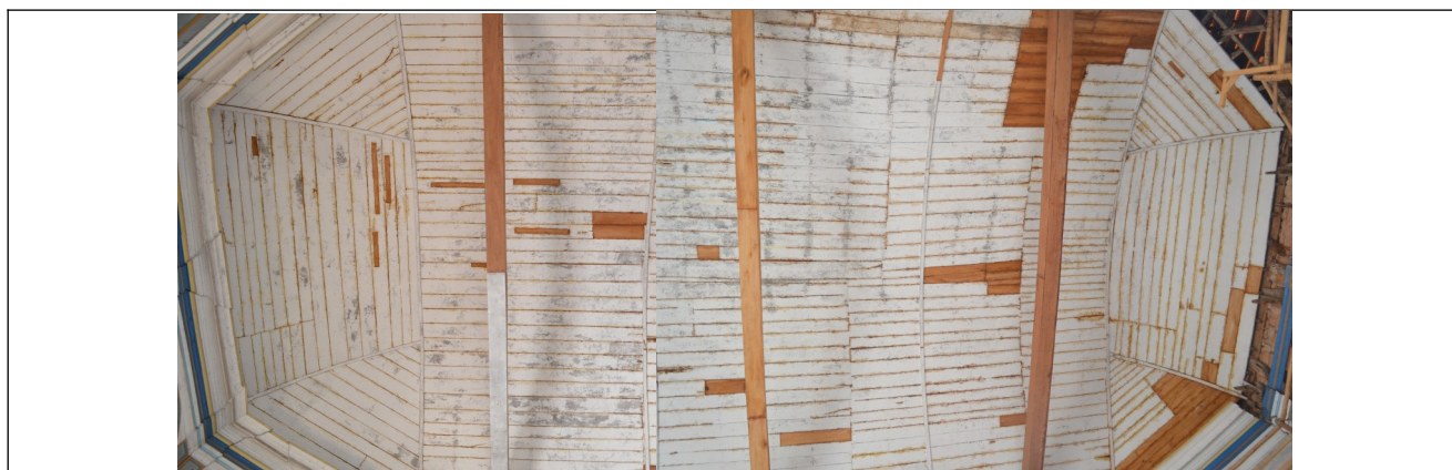
Figura 54 – Aspecto geral do forro da nave da Igreja Matriz de Nossa Senhora da Conceição.
