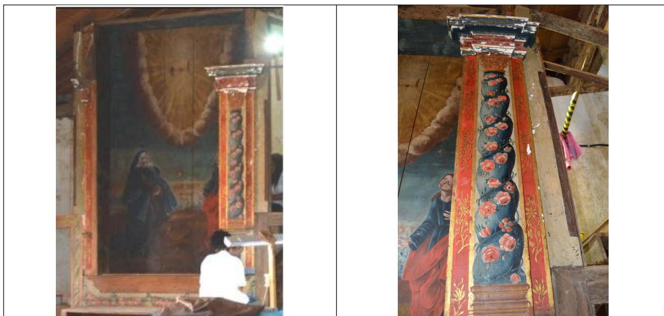
Figuras 18 e 19 – No primeiro registro verifica-se o retábulo do Senhor do Bonfim. No segundo, detalhe deste elemento. É possível notar a presença de áreas niveladas, prontas para serem reintegradas.
