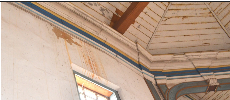
Figura 49 – Detalhe da cimalha da nave. É possível observar que ainda se encontra repintada.
