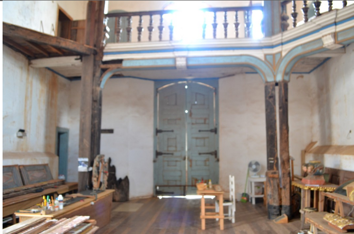
Figura 45 – Na primeira foto verifica-se o aspecto geral das colunas, pilastras e arcadas da nave, referente ao coro.
