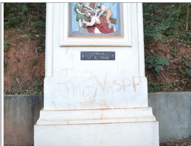
Figura 03 – Pichações e inscrições nas alvenarias das estações. .
