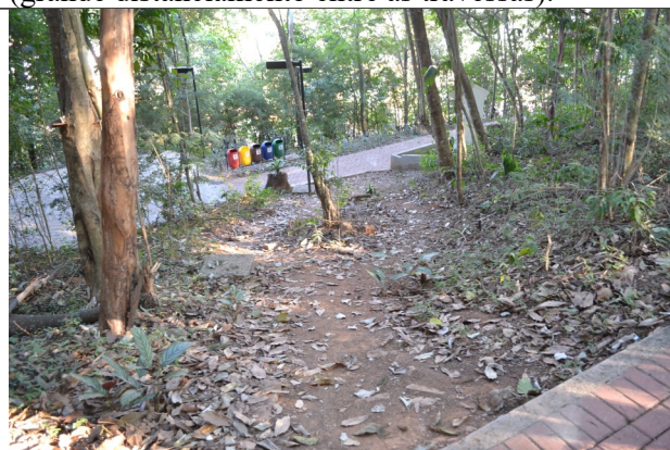
Figura 06 – Local onde seria construída a escada para encurtar caminho entre as estações.
