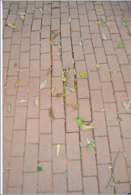
Figuras 09 e 10 – Desnívelamento do piso da pista.
