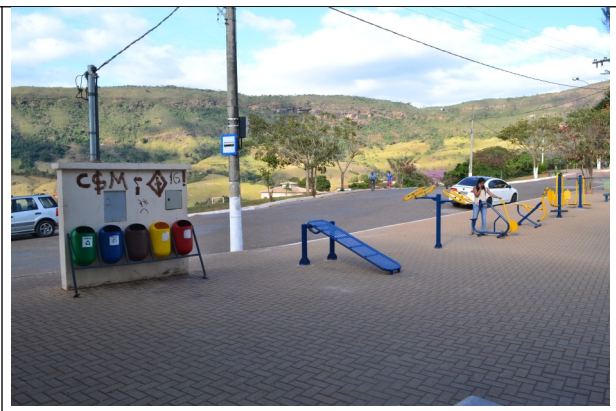
Figura 02 – Vista geral do local onde foram instalados os aparelhos de ginástica. Verifica-se a existência de pichações / inscrições junto ao padrão de energia.
