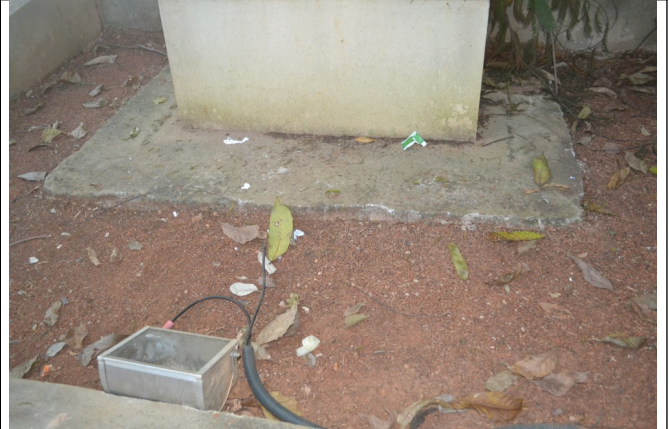
Figura 14 – Fiação e eletroduto aparente. Ausência de tratamento paisagístico no canteiro existente na base da estação.
