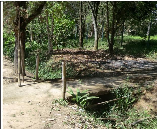
Figura 18 – Ponte em mau estado de conservação e sem a devida proteção.
