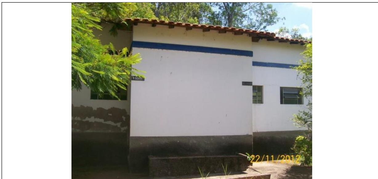
Figura 26 – Edificação que abriga os banheiros com descolamento de pintura e vidros quebrados.
