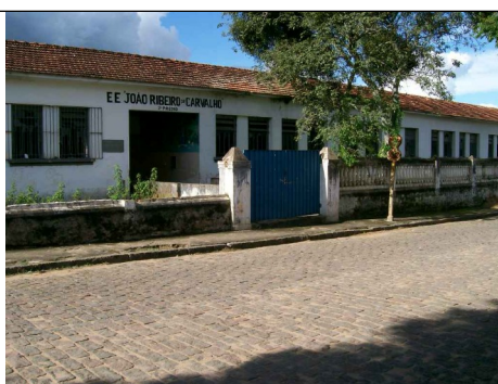
Figura 17 – Vista da fachada frontal, muro de fechamento e portão de acesso.
