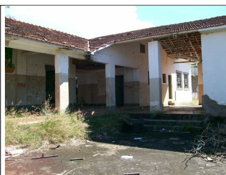
Figura 20 – Área da cantina e vestiários à esquerda, secretaria e sala de professores ao centro e corredor para salas de aula à direita.
