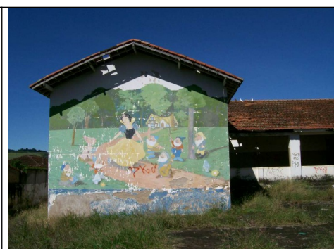
Figura 18 – Vista do acréscimo bloco de salas de aula, com pintura em motivos infantis.
