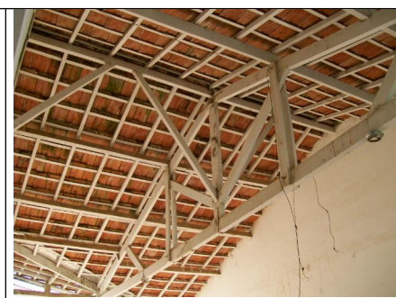
Figura 27 – Forro de telhas vãs no espaço livre próximo ao corredor
