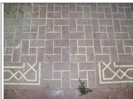
Figura 22 – Piso de ladrilho hidráulico.
