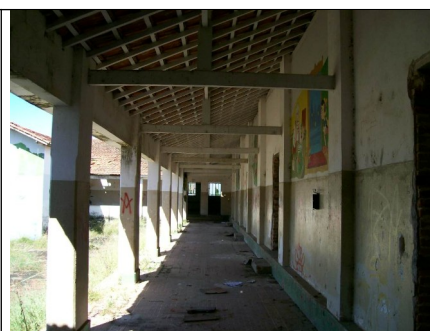
Figura 26 – Forro de telhas vãs no corredor de acesso às salas de aula
