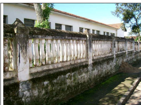
Figura 16 – Fechamento do lote: muro de alvenaria de tijolos e pedra com balaústres.
