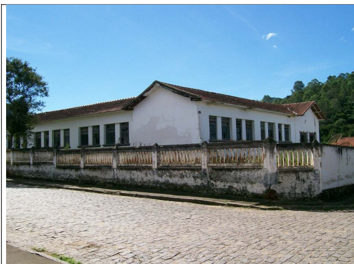
Figura 02 – Vista geral do prédio
