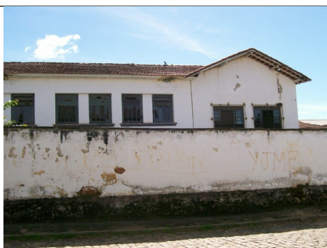
Figura 12 – Fachada lateral direita
