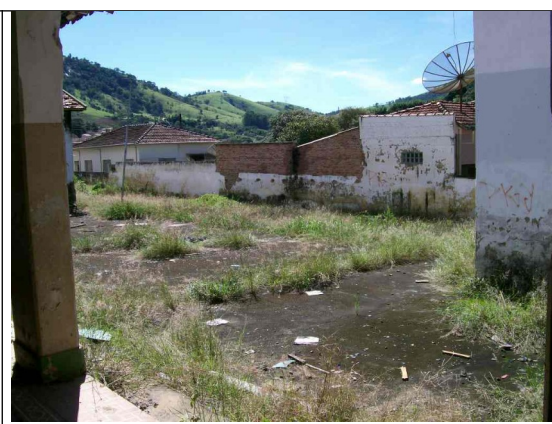
Figura 16 – Pátio central e área livre nos fundos do terreno.
