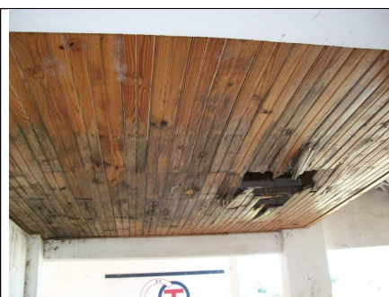
Figura 25 – Forro de lambris de madeira.
