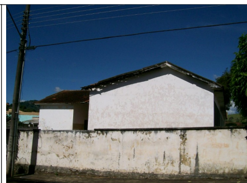
Figura 13 – Fachada lateral esquerda.
