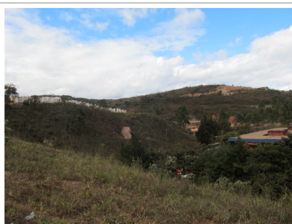
Figura 6 – Muro do Condomínio Goiabeiras (acima na foto) em relação à rodoviária (à direita).
