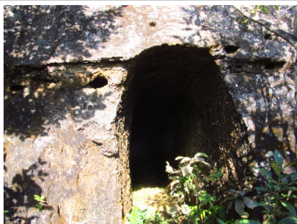
Figura 24- Galeria localizada no terreno denominado Santa Vitória em Congonhas. Foto da vistoria realizada em 16/06/2012.
