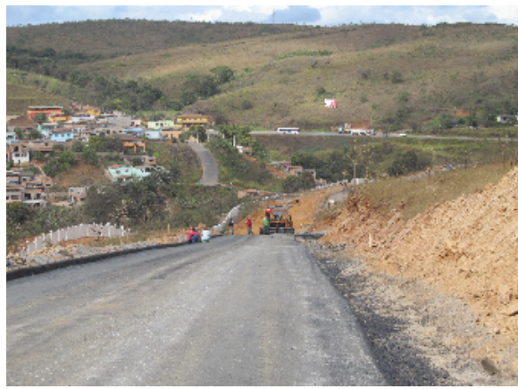
Figuras 7 e 8 – Obras de asfaltamento e colocação de meio-fios no Condomínio Goiabeiras
