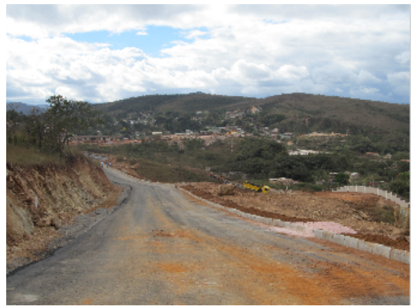
Figuras 7 e 8 – Obras de asfaltamento e colocação de meio-fios no Condomínio Goiabeiras
