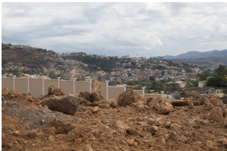
Figura 26- Imagem das obras no Condomínio Goiabeiras, destacando ao fundo a Basílica de Bom Jesus do Matozinhos.
