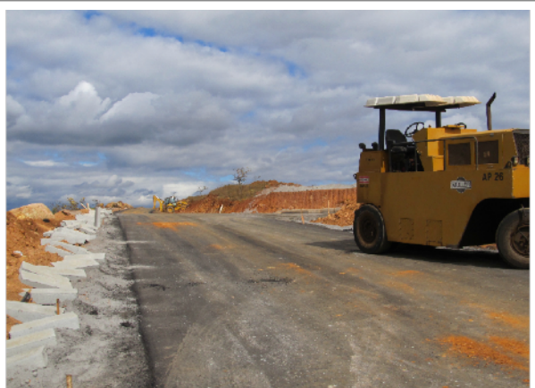
Figuras 7 e 8 – Obras de asfaltamento e colocação de meio-fios no Condomínio Goiabeiras
