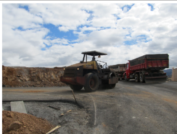
Figuras 7 e 8 – Obras de asfaltamento e colocação de meio-fios no Condomínio Goiabeiras
