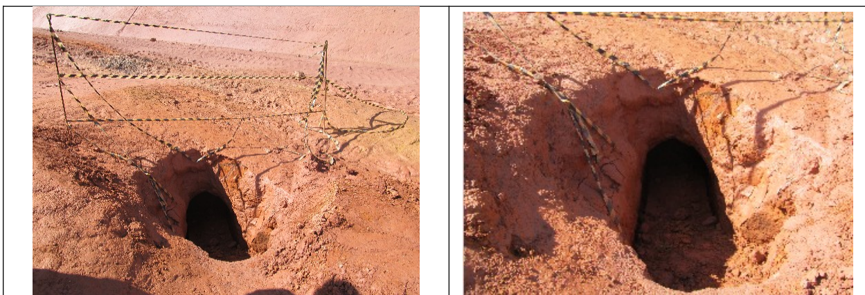
Figuras 12 e 13- Fotografias do túnel feitas durante a vistoria de 16/06/2012.
