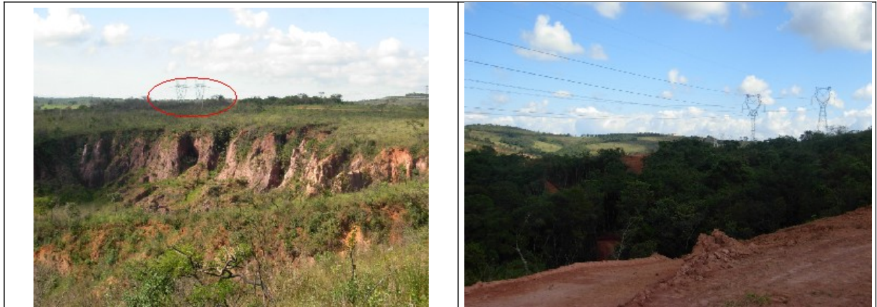
Figura 14 e 15- Torres de transmissão de energia elétrica (assinaladas de vermelho na 1ª imagem) instaladas numa cava de mineração antiga.
