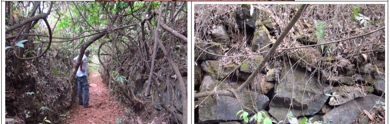
Figuras 12, 13 e 14 - Antigo canal existente na área do condomínio Goiabeiras , com detalhe de sua estrutura na última imagem.
