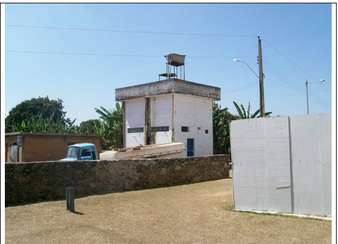
Figura 07 – Tapume de frente à igreja, caixa d'água e caminhão pipa.
