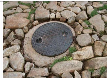
Figura 12 – Caixa de passagem de esgoto.
