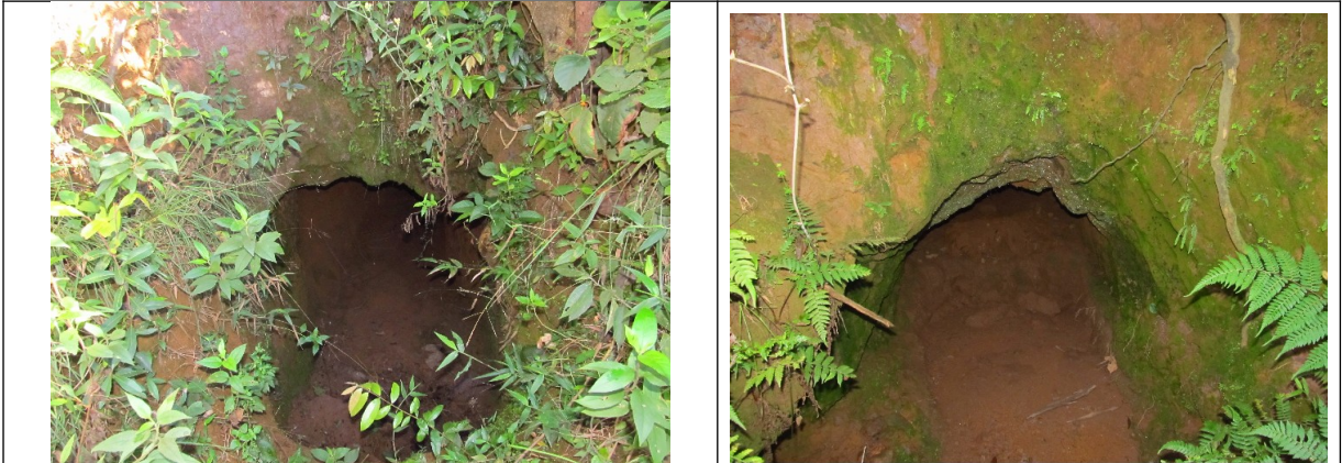
Figuras 07 e 08- Imagens de galerias encontradas no terreno Santa Vitória na vistoria de 16/06/2012.
