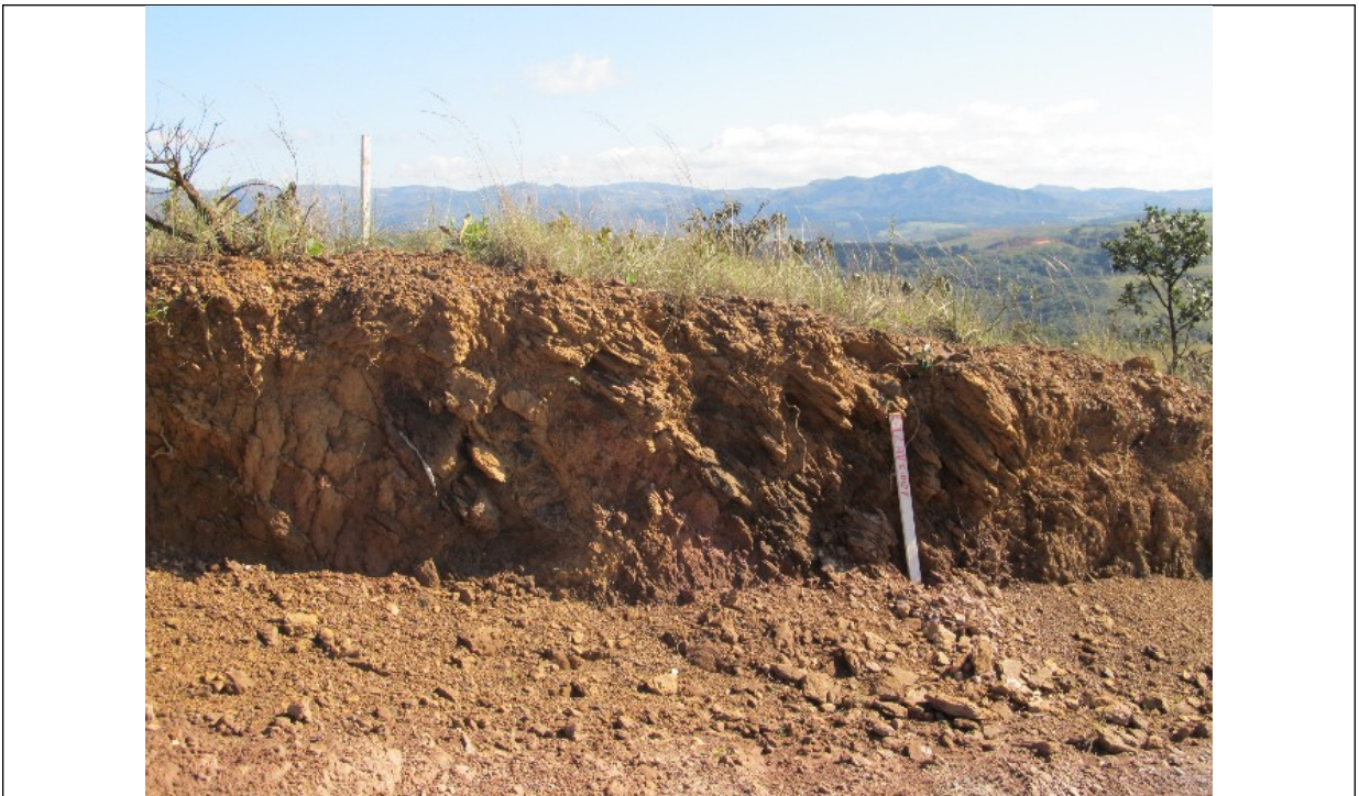
Figuras 15- Imagem que retrata a movimentação de terra e a implantação de estacas no Santa Vitória.
