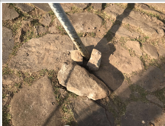
Figura 13 - Danos no encaixe dos balizadores no solo.
