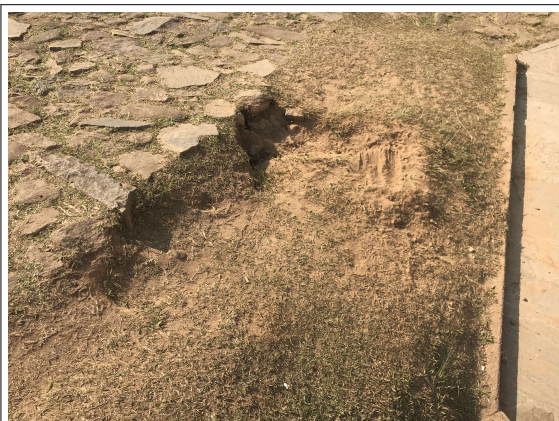
Figura 05 - Falhas no piso do jardim.
