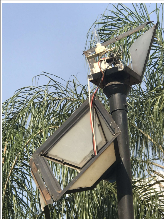
Figura 07 - Luminária danificada.
