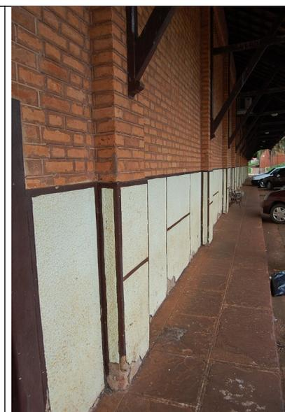
Figura 05 – Instalação de barrado.
