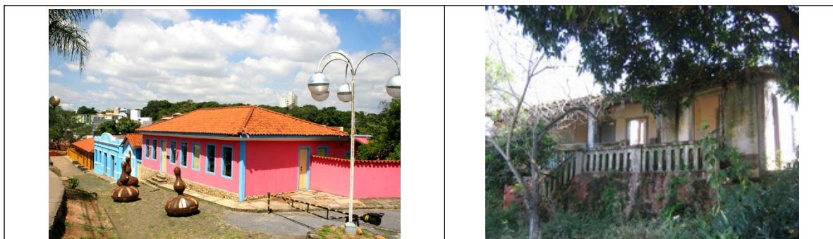
Figuras 10 e 11- Bens culturais tombados em Contagem: Conjunto Arquitetônico da Rua Dr. Cassiano e Fazenda Vista Alegre. Fontes: http://www.defender.org.br/contagemmg-nosso-lugar-nosso-patrimonio/ e http://www.folhadecontagem.com.br/site/modules . Acesso em novembro/2012.
