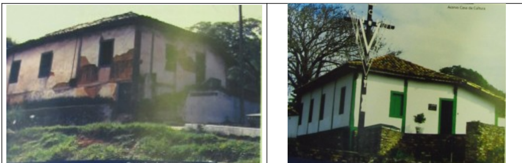
Figuras 16 e 17 – Casa da Cultura de Contagem: antes e depois da restauração. Fonte: Documentação apresentada pelo município ao IEPHA.
