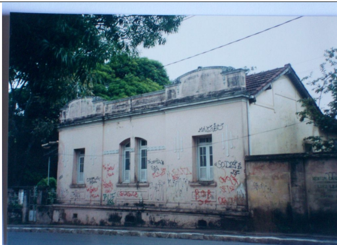
Figura 06 - Foto das fachadas frontal e lateral direita do casarão antes da demolição.
