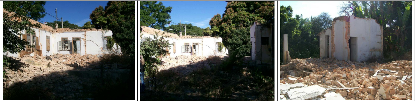
Figuras 09, 10 e 11 – Vista das paredes remanescentes a partir da parte interna do imóvel.
