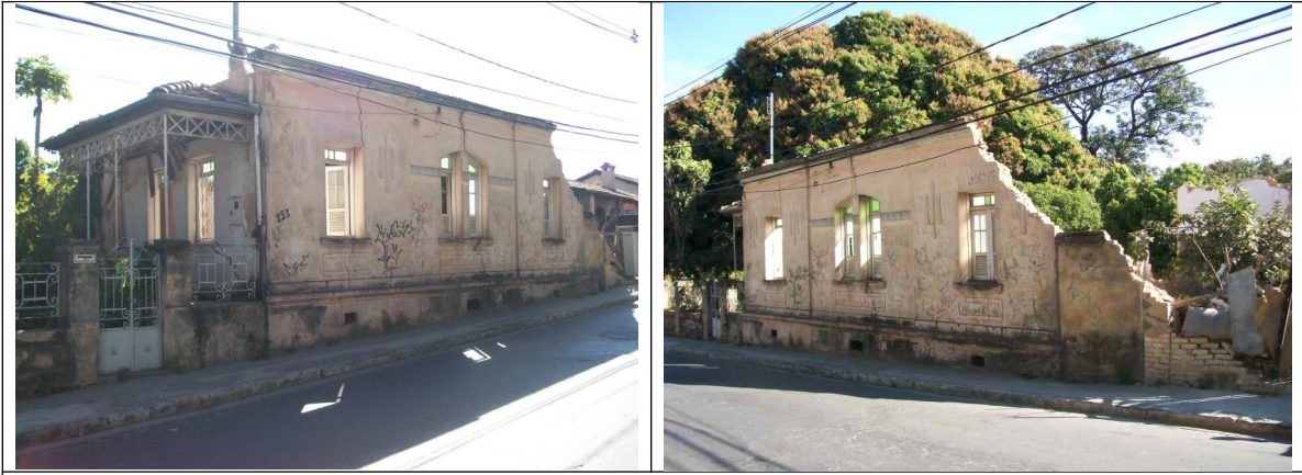
Figuras 07 e 08 – Vista das paredes remanescentes e alpendre lateral.
