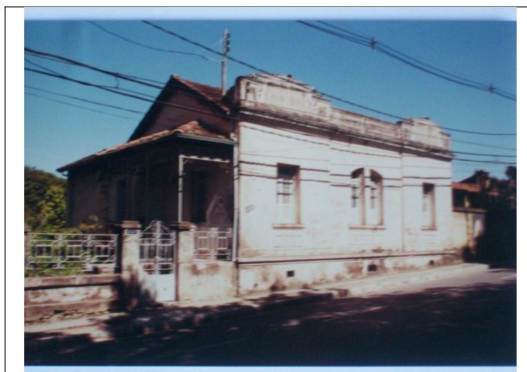
Figura 04 – Fotografia da fachada e lateral esquerda do casarão, antes da demolição, existente no inventário.
