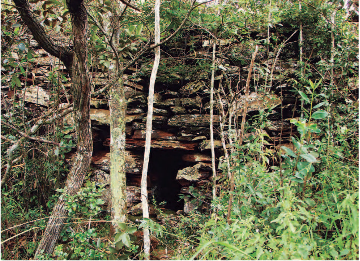
Figura 17 - Galeria sob estrutura de adução para transposição de drenagem componente do Complexo de Aredes (Itabirito/MG). Foto: Rogério Tobias Junior.
