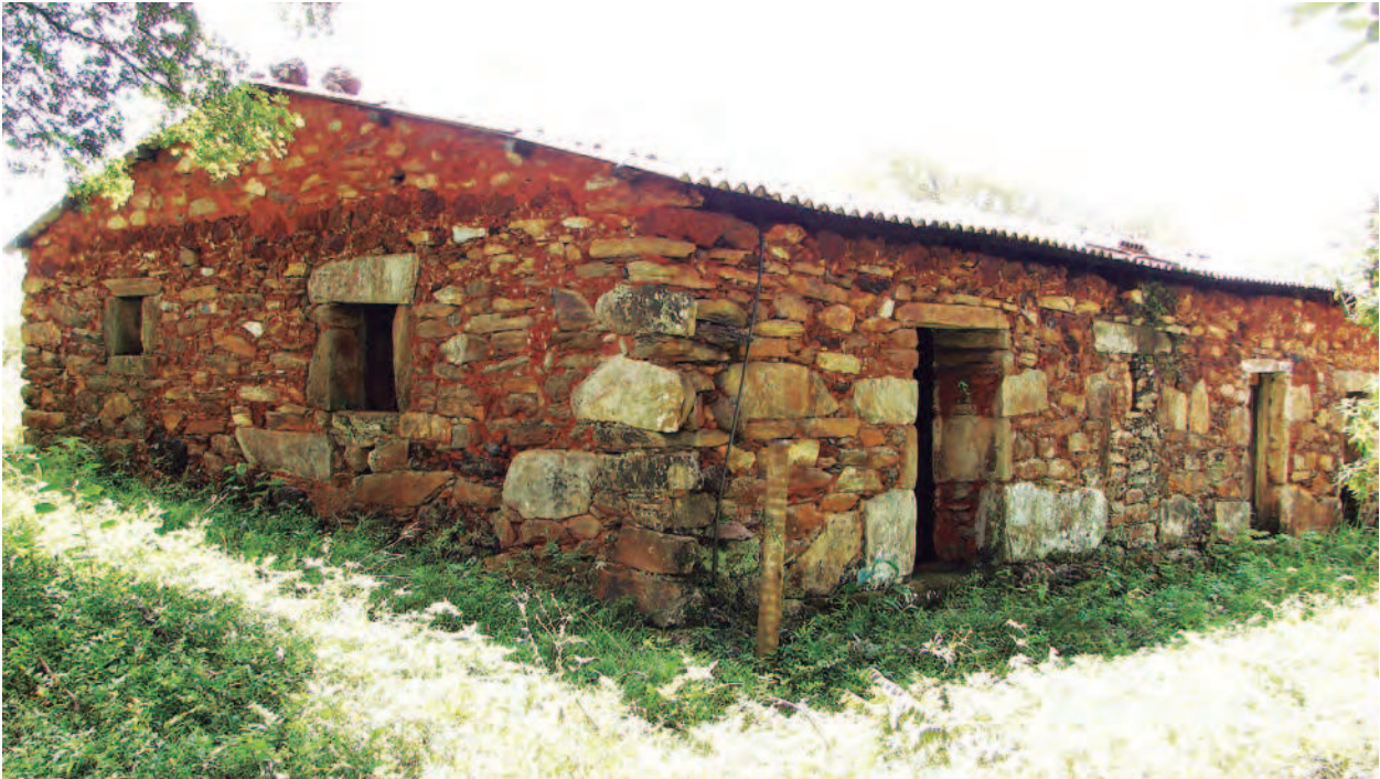
Figura 15 - Edificação componente do Complexo de Aredes (Itabirito/MG). Foto: Rogério Tobias Junior.
