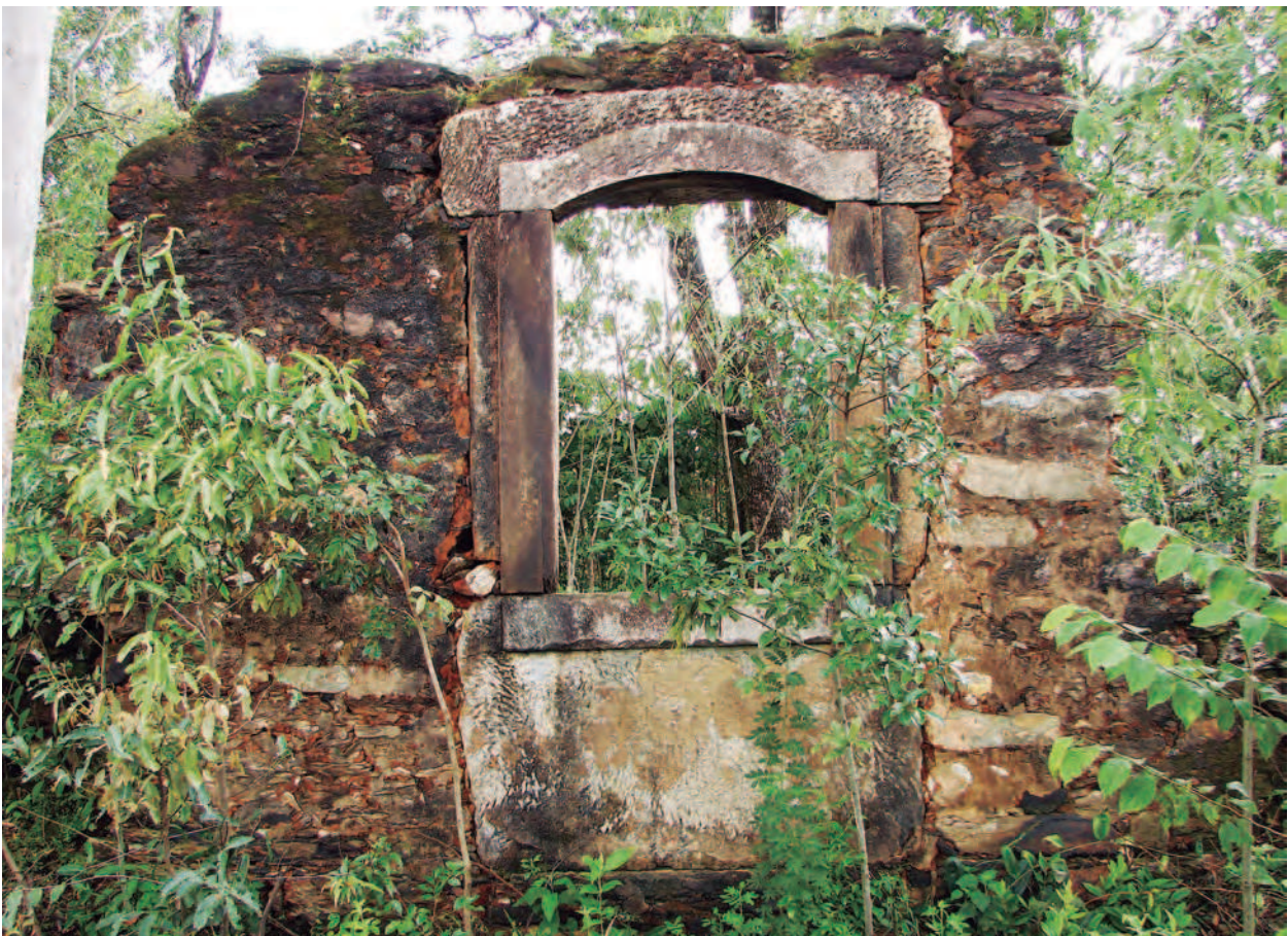
Figura 16 - Janela remanescente de edificação em ruínas do Complexo de Aredes (Itabirito/MG). Foto: Rogério Tobias Junior.
