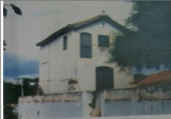
Figura 08 - Capelinha do Lafeté. Rua João Lafeté, s/n - Coração de Jesus/MG. Fonte: Documentação do ICMS 1996/1999 enviada pelo município ao IEPHA.
