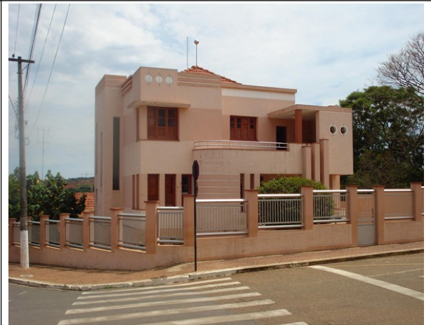
Figura 05- Casarão restaurado em Coromandel. Fonte: http://www.geolocation.ws . Acesso fevereiro de 2013.
