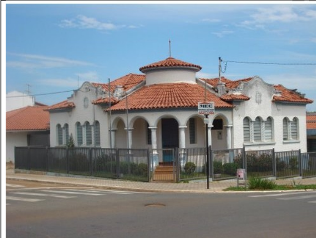
Figura 04- Prefeitura Municipal de Coromandel. Fonte: http://www.panoramio.com . Acesso fevereiro de 2013.
