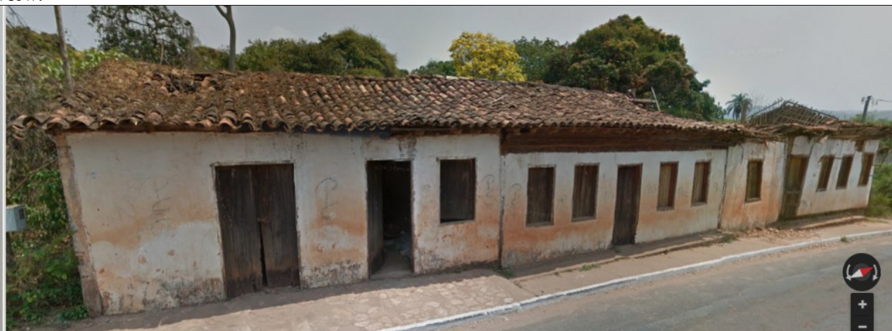
Figura 09 – Imagem dos imóveis em estado de degradação, datada de setembro de 2012. Fonte: Google Street View.
