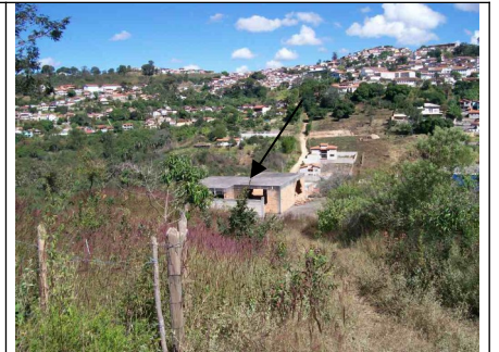
Figura 14 – Lotes cercados, via sem calçamento e construção irregular (seta).
