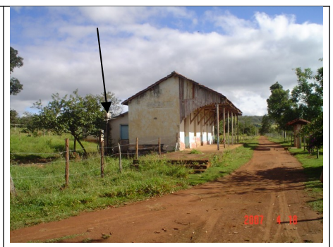
Figura 23 – Acréscimo de edificação nos fundos da estação, que descaracteriza o edifício.
