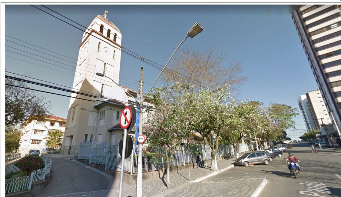
Figura 4 - Ago/2011 – A fachada lateral esquerda (sentido do templo) recebe insolação. Fonte: Google street view .
