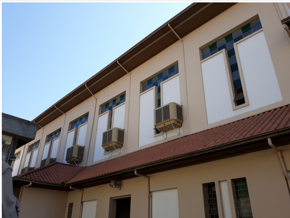
Figura 6 – Climatizadores instalados na fachada lateral do Santuário de Santo Antônio. Fonte: CPPC
