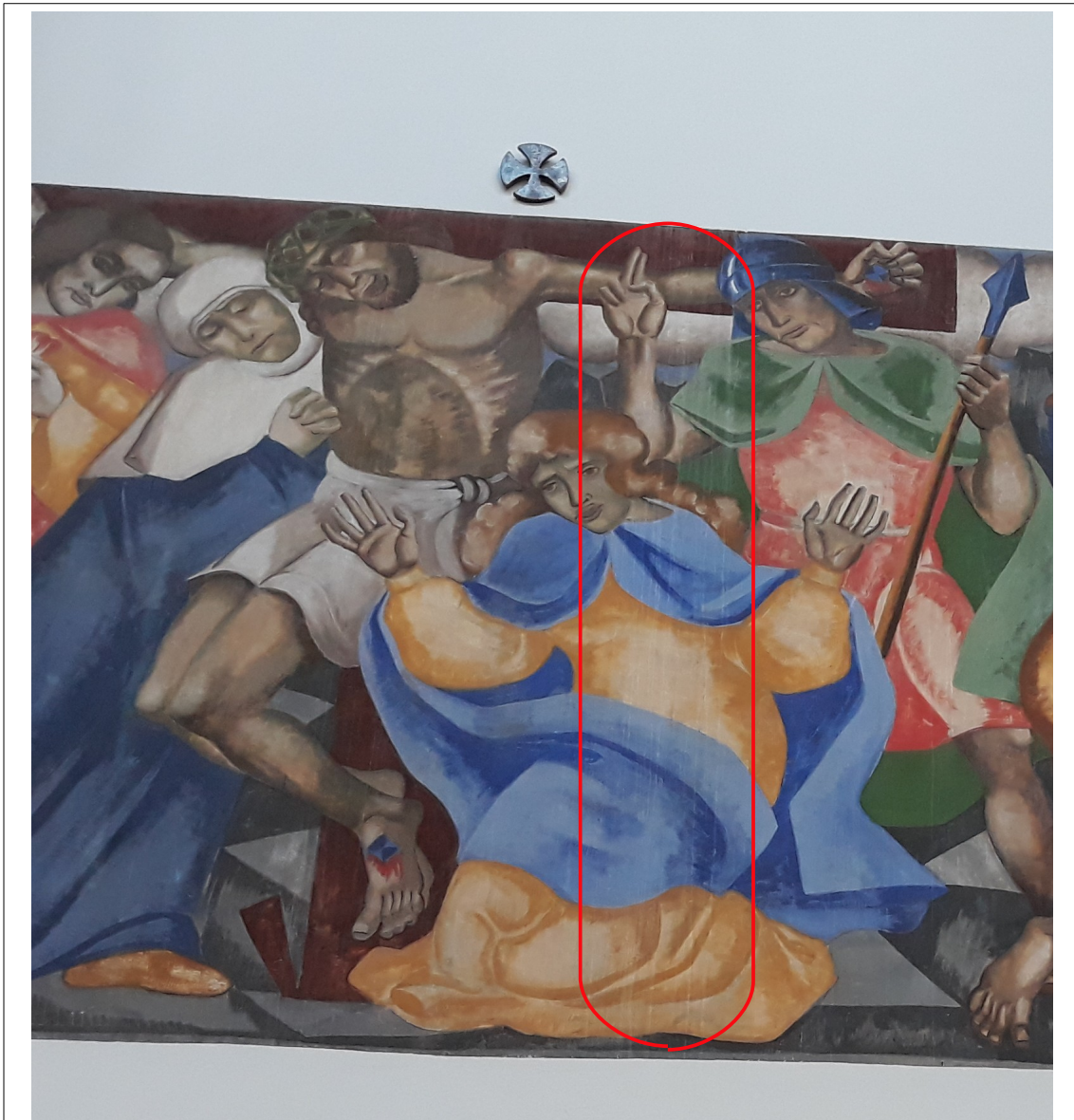
Figura 14 – Detalhe do painel evidenciado na figura 13. Observa-se, onde está indicado, marcas longitudinais que se destacam por estarem desbotadas em relação ao todo do painel. Fonte: CPPC.
