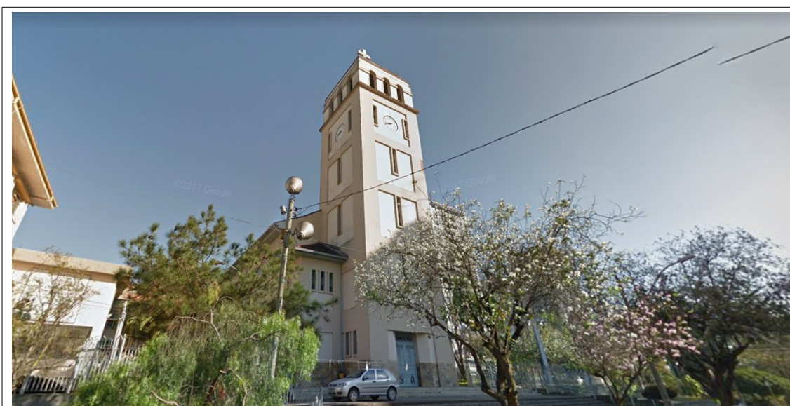
Figura 5 - Ago/2011 – A fachada lateral direita (sentido do templo) não recebe insolação, conforme se verifica. É nesta fachada que foi instalada a climatização. Fonte: Google street view .
