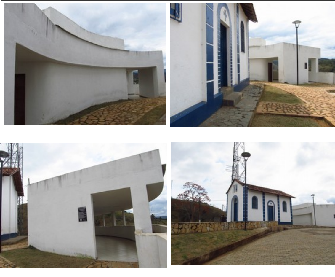
Figuras 13, 14, 15 e 16- Edificação construída aos fundos da Capela do Cruzeiro e sua interferência na ambiência do bem. Fotos da vistoria.
