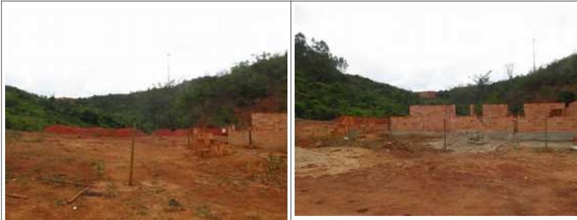
Figuras 39 e 40- Obras realizadas nas proximidades do Complexo da Barragem. Fotos da vistoria.
