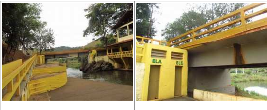
Figuras 14 e 15- Complexo da Barragem em Dom Joaquim, destacando a queda d'água, as passarelas, os muros e guarda corpos. Fotos da vistoria.
