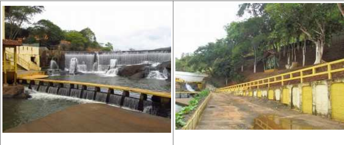
Figuras 12 e 13- Complexo da Barragem em Dom Joaquim, destacando a queda d'água, as passarelas, os muros e guarda corpos. Fotos da vistoria.
