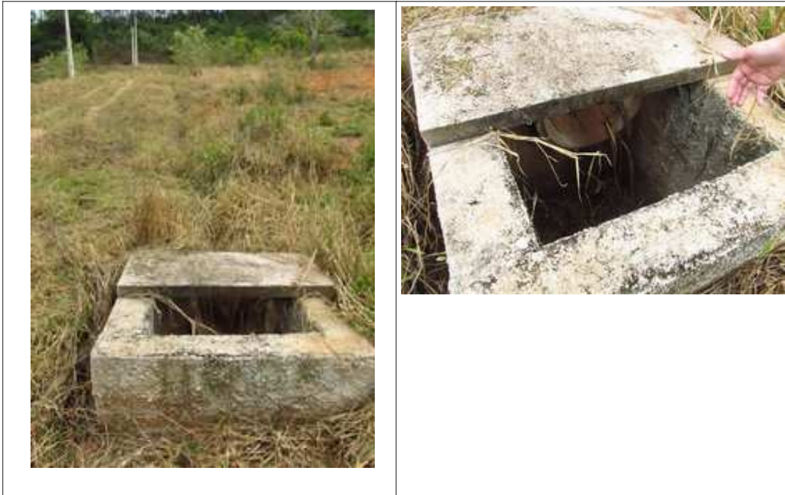
Figuras 26 e 27- Estruturas integrantes do aqueduto implantadas próximas ao Complexo da Barragem pela Anglo American. Fotos da vistoria.
