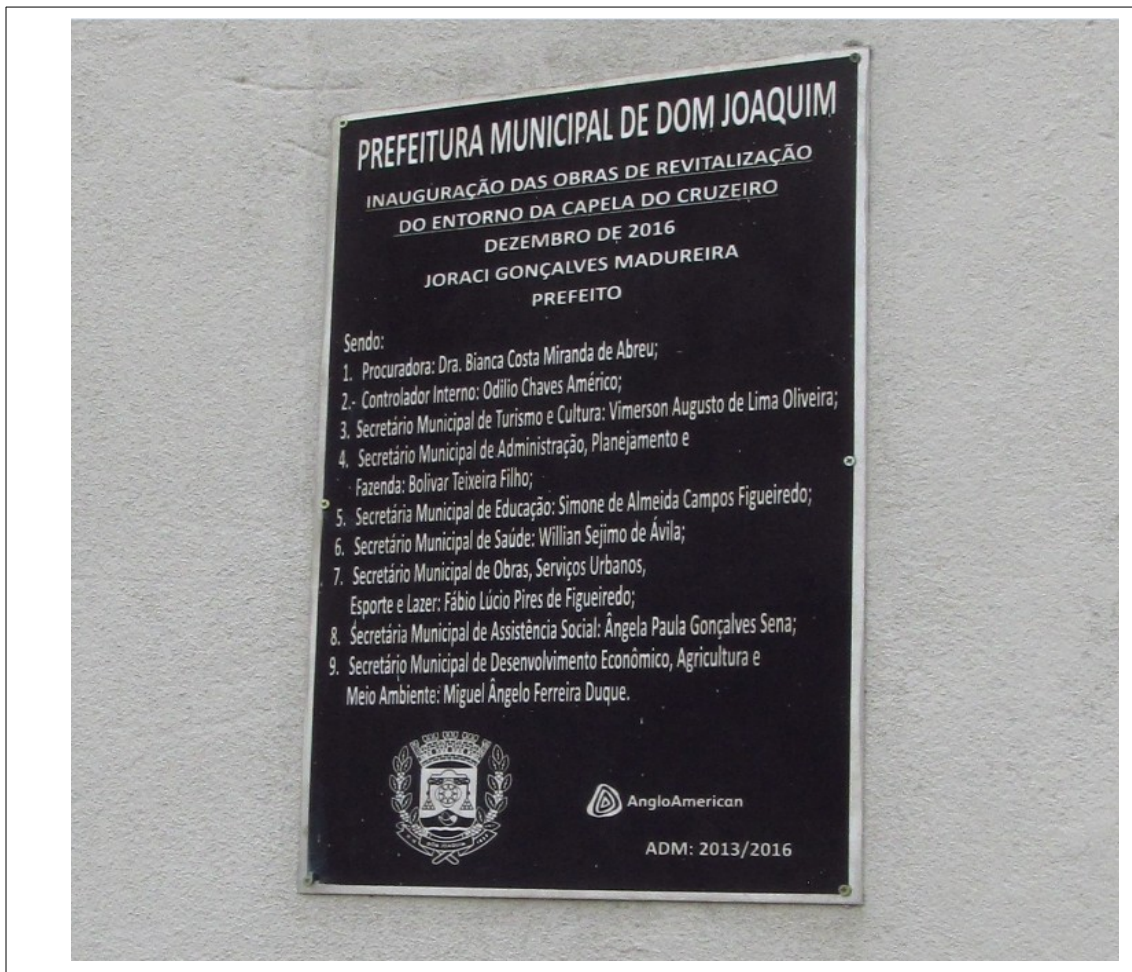
Figura 1- Placa de inauguração implantada na nova construção erguida aos fundos da Capela do Cruzeiro em Dom Joaquim. Foto da vistoria realizada em 07.08.2018.
