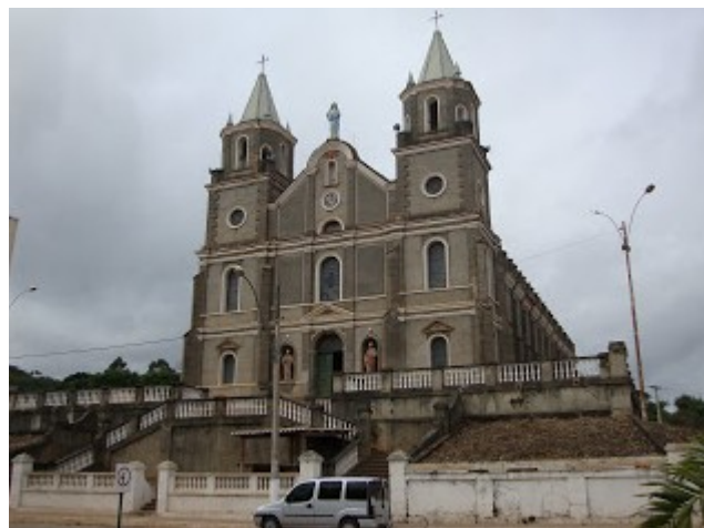
Figura 3- Igreja de Nossa Senhora das Dores. Fonte: https://italostephanarquitecto.blogspot.com/2010/05/dores-do-turvo-patrimonio-em-risco.html . Acesso 06.05.2019.
