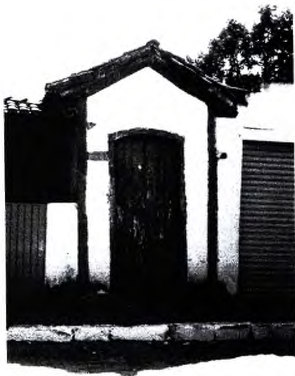
O mais antigo dos passos. Possui estrutura autônoma em madeira e vedação em pau-a-pique. A porta tem quadros em verga curva, alteada, e vedação em duas folhas de madeira. A cobertura, estruturada em madeira, possui duas águas e telhas tipo capa e bica.
