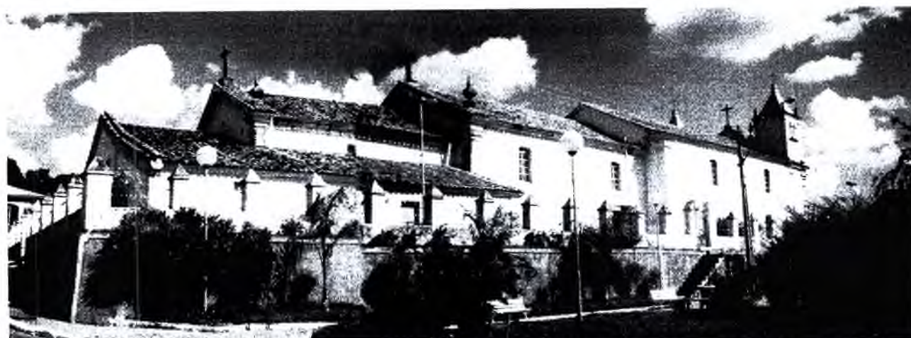
Fachada lateral - Jogo de volumes sucessivos com alturas diferenciadas. Representam respectivamente a sacristia, a segunda nave, a primeira nave e a capela-mor.
