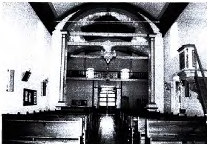
Interior da Igreja - Ao fundo, a nave de entrada com coro em estrutura de madeira e balustrada recente. O tapa vento é em madeira e vidro fantasia. À direita, o púlpito com estrutura em pedra e detalhes em rocalhas e fechamento em madeira pintada com motivos florais.
