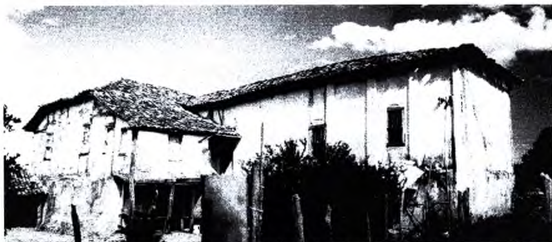
Fachadas 3 e 4, voltadas para o pátio. O bloco à esquerda, estruturado em madeira e vedado em pau-a-pique, é representativo da primeira ocupação, no séc. XVIII. À direita, o acréscimo, construído em fins do séc. XIX, possui vedação em tijolos queimados.
