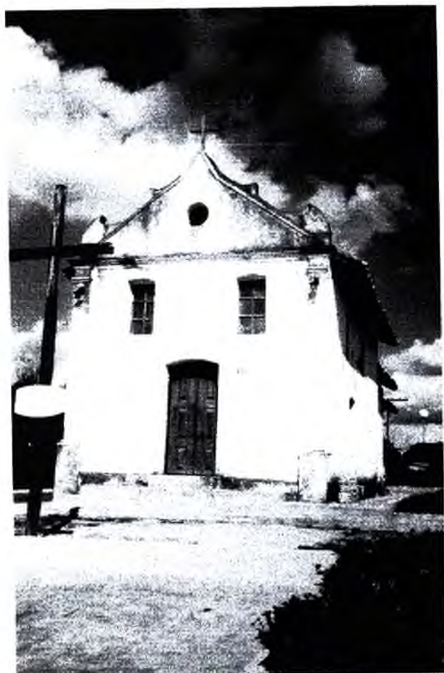
Fachada frontal - O frontão, com um único óculo, é trabalhado em cimento. A porta, em vergas retas, possui duas folhas de abrir em madeira almofadada. As janelas possuem esquadrias metálicas em caixilhos de vidro.
