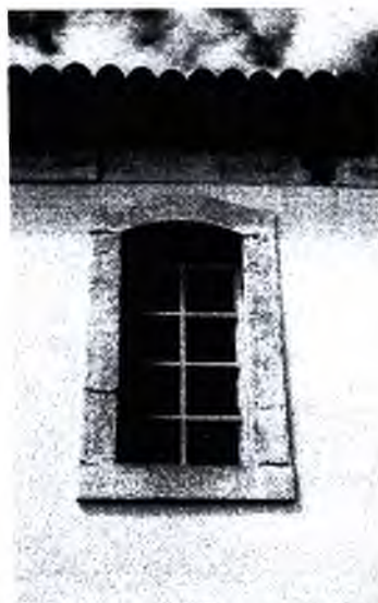
Janela de verga alteada e vedação em caixilho de vidro.
