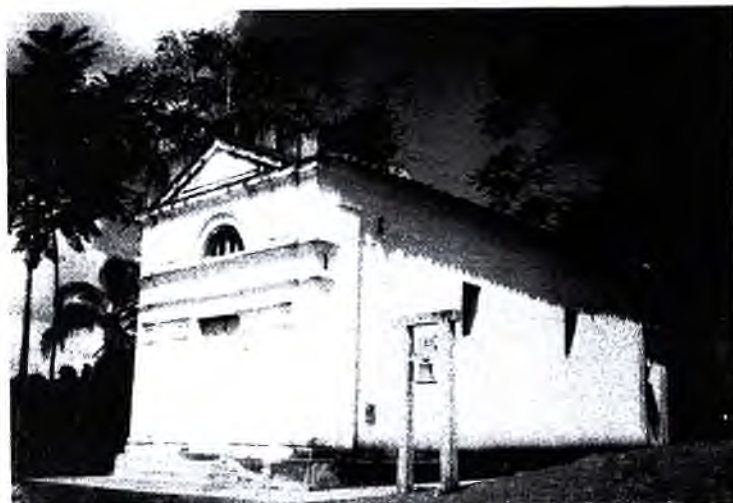
Fachada lateral e Torre sineira
