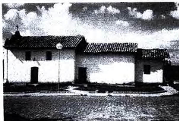
Fachada lateral - A nave e a capela-mor são construídas em adobe. Já a sacristia, proveniente de reforma recente, é constituída de tijolos queimados. O telhado, em duas águas, é estruturado em tesouras de madeira e coberto com telhas tipo capa e bica.
