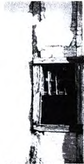
Detalhe de janela
