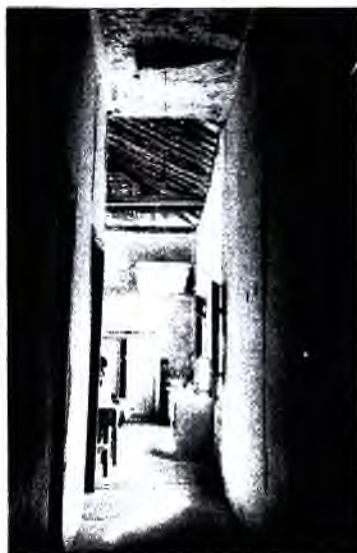
Corredor de acesso à cozinha. Forro de esteira e piso em tábuas.
