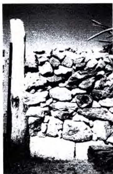
Muro de pedras do curral.
