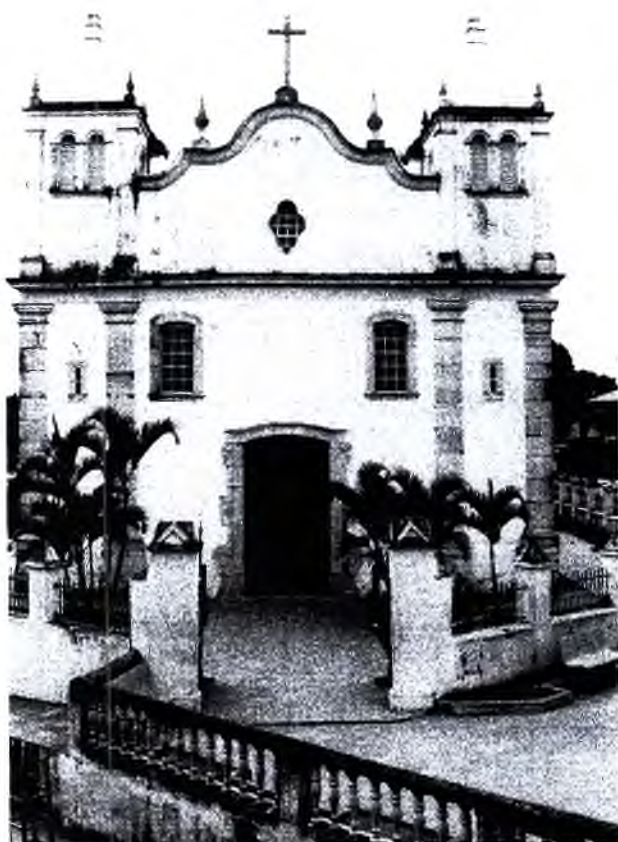
A fachada principal registra dois momentos distintos de ocupação. O retângulo que forma a base e o arremate do frontão e torres, construídos posteriormente.
