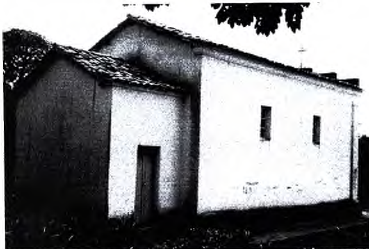
Fachada posterior - O telhado se desenvolve em duas águas com caimento lateral, estrutura de madeira e telhas tipo capa e bica.
