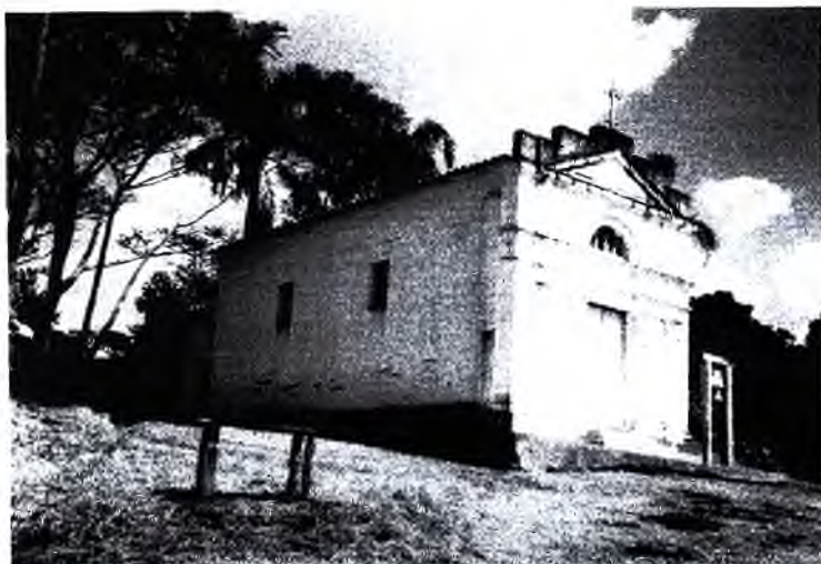
Fachada lateral - Janelas em vergas retas com caixilhos de vidro.
