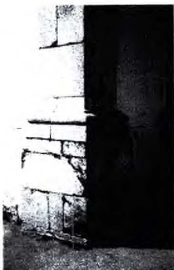
As pilastras salientes são trabalhadas em pedra de quartzito, com a base alargada e fuste reto e simples.
