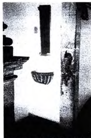
Bacia em pedra sabão fixada na parede, próximo à porta lateral.
