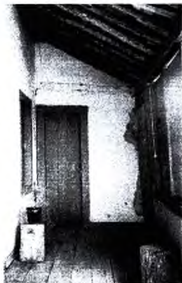
Vista interna da varanda. Telhado aparente e piso em tábuas.
