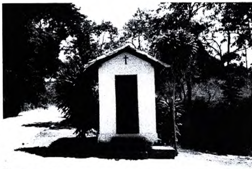
Fachada frontal - A construção possui estrutura autoportante em tijolos queimados. A porta tem vergas retas embutidas e vedação em duas folhas. A cobertura, estruturada em madeira, possui duas águas e telhas tipo capa e bica.
