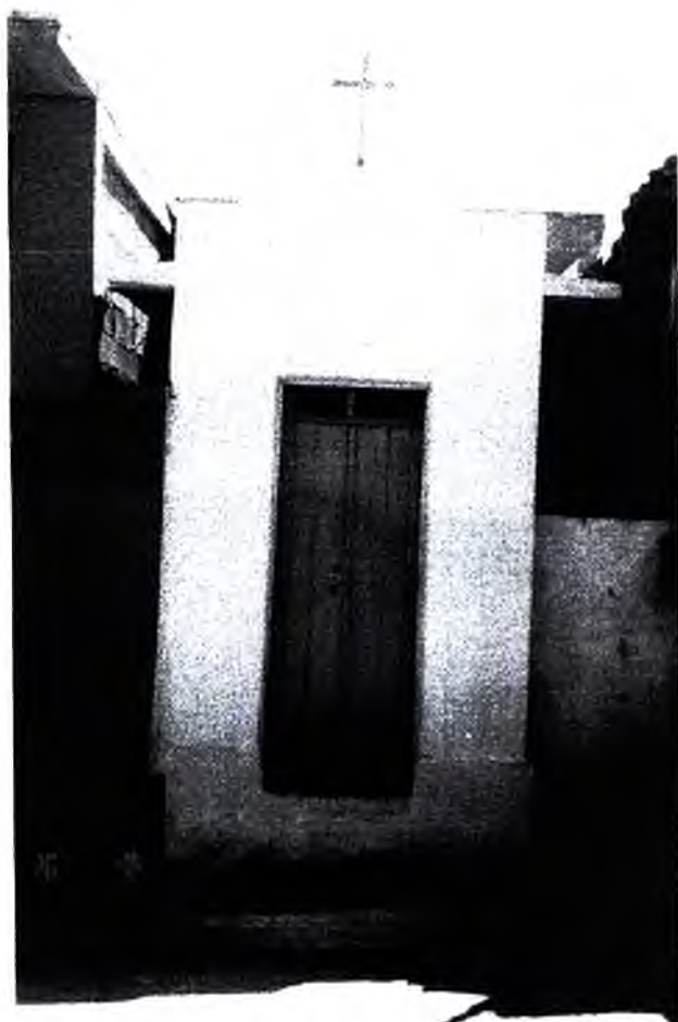
Fachada frontal - A construção é entalada entre duas casas. Possui estrutura autoportante em tijolos queimados e cobertura em laje plana. A porta de madeira possui duas folhas de abrir.
