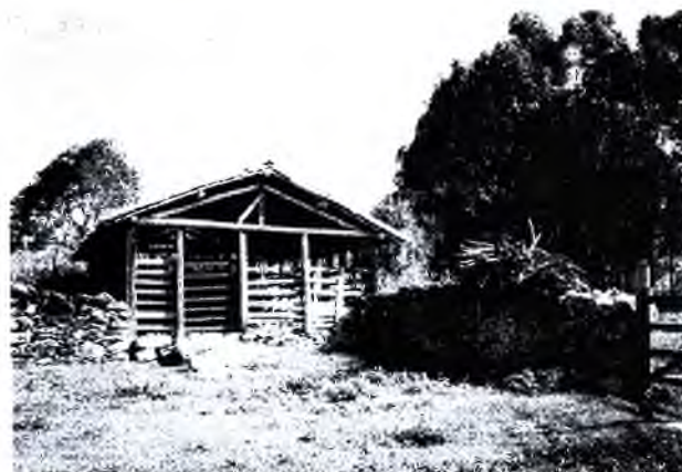
O Rancho, localizado no curral, possui telhado em duas águas, estruturado em madeira, com telhas tipo capa e bica.
