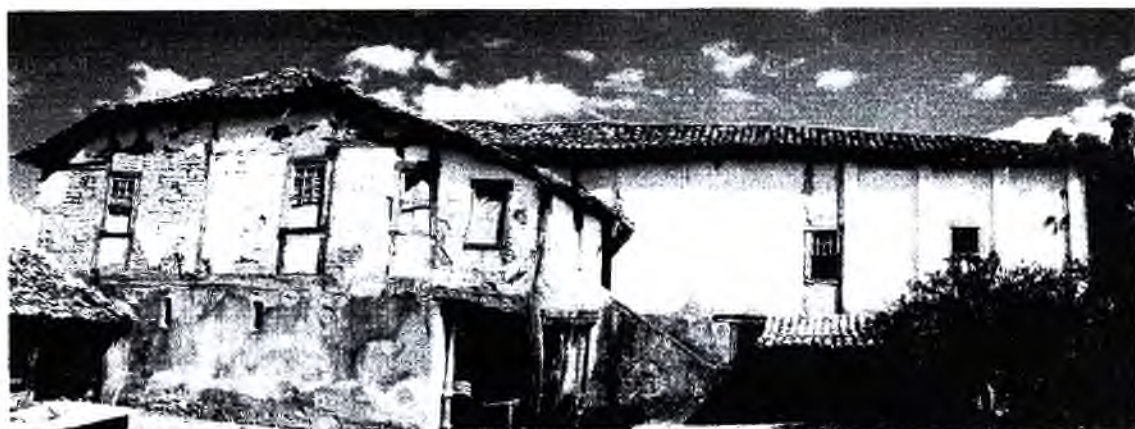
Fachada 4. À direita, o puxado do fogão de lenha. O telhado, estruturado em tesouras de madeira, possui telhas do tipo capa e bica.
