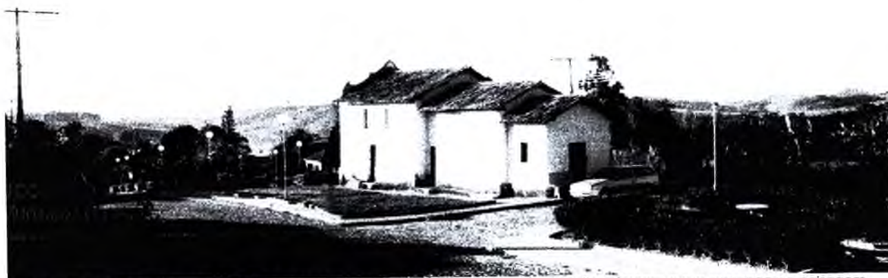
A capela se localiza em um grande largo situado no alto do morro. Os vazios à sua volta reforçam a sua presença na paisagem.
