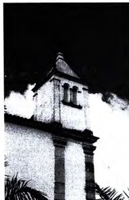
Torre com duas aberturas com vergas em arcos plenos e fechamento em veneziana metálica.
