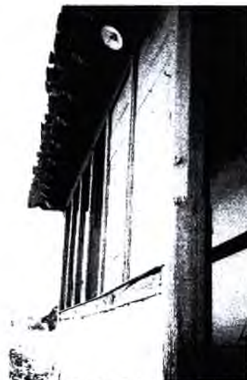
Fachada frontal. Beiral em cachorrada com forro de madeira.
