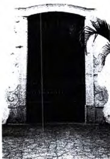
A portada possui ombreiras arrematadas em pedra com detalhes de volutas e representações fitomórficas. A porta, em madeira almofadada sem pintura, possui duas folhas.
