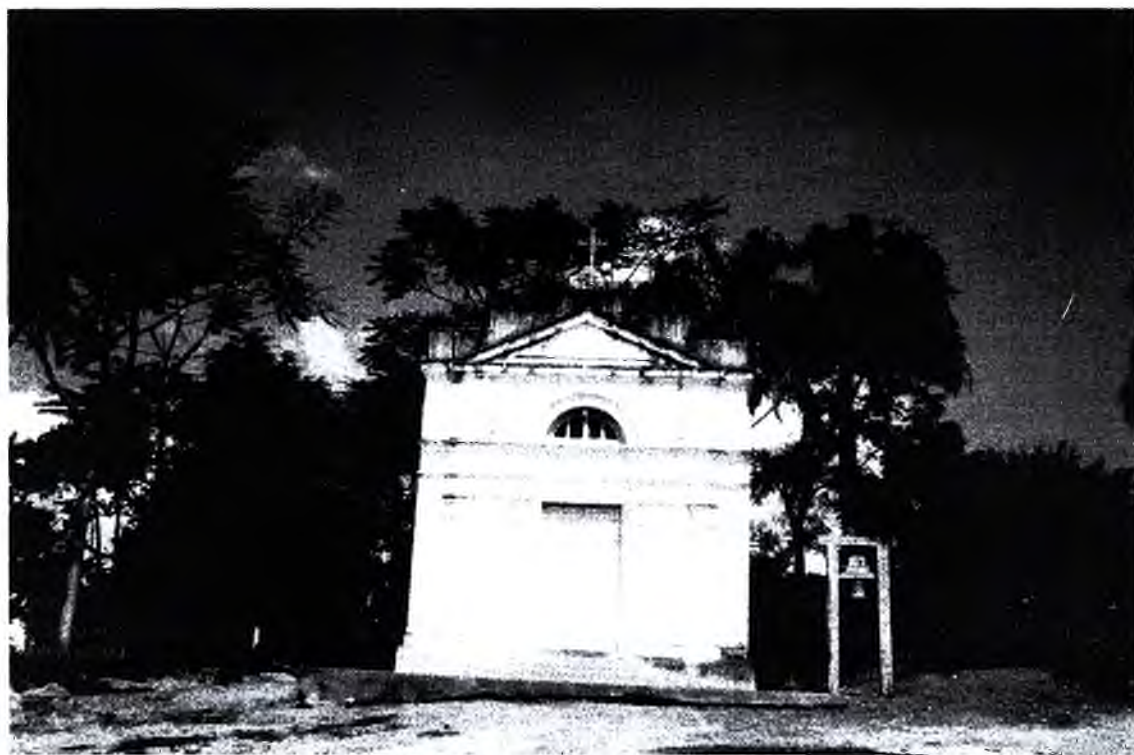
Fachada Frontal. Os detalhes, de inspiração clássica, são em massa de cimento. As pilastras salientes, com capitel frisado, têm a base alargada e fuste trapezoidal. A fachada possui entablamento frisado, sobre o qual se erguem o frontão triangular e o contra-frontão com detalhes em alturas diferenciadas. A porta, em verga reta, possui duas folhas de madeira almofadada e o óculo, em meia circunferência, possui caixilhos fixos em madeira. À direita, torre sineira.
