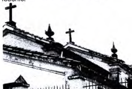
Detalhes construtivos - Cantarias em pedra trabalhada, cimbalhas, pináculos e cruzes.
