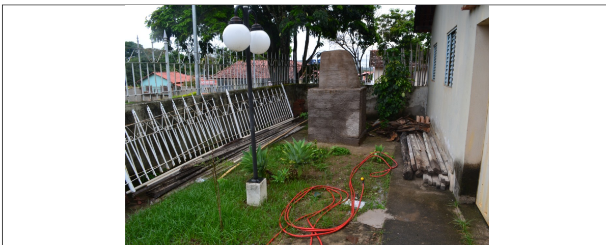
Figura 10 – Parte frontal da igreja de São Geraldo. Nota-se a deposição de materiais nesta área. Fonte: CPPC.
