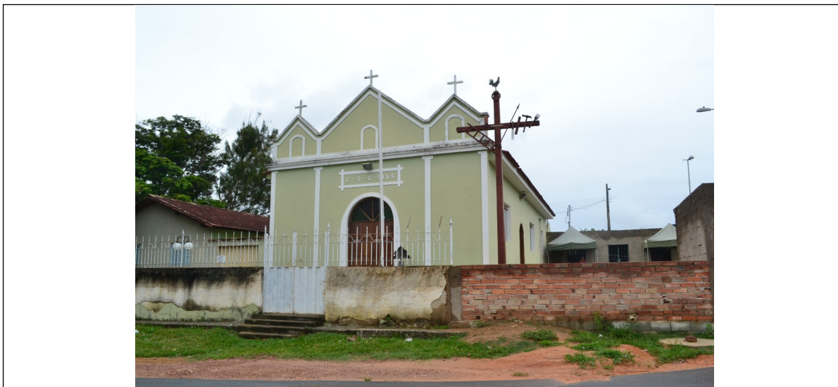
Figura 2 – Fachada da Igreja de São Geraldo.
